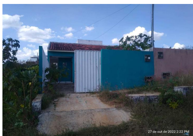
Vizinho à esquerda - Fachada
