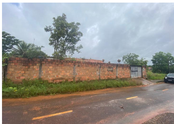
Fachada do avaliando, vista 02
