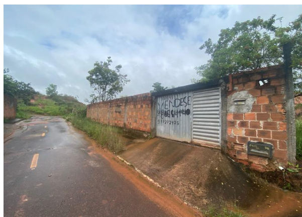
Fachada do avaliando, vista 03
