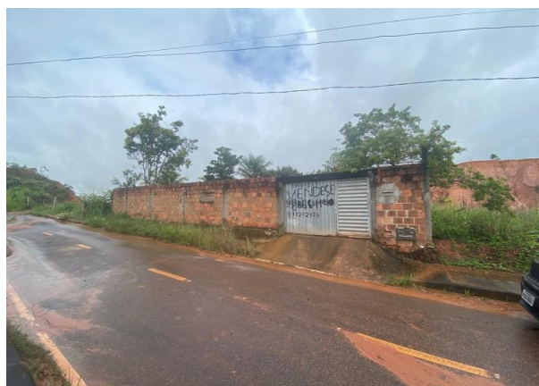
Fachada do avaliando, vista 01
