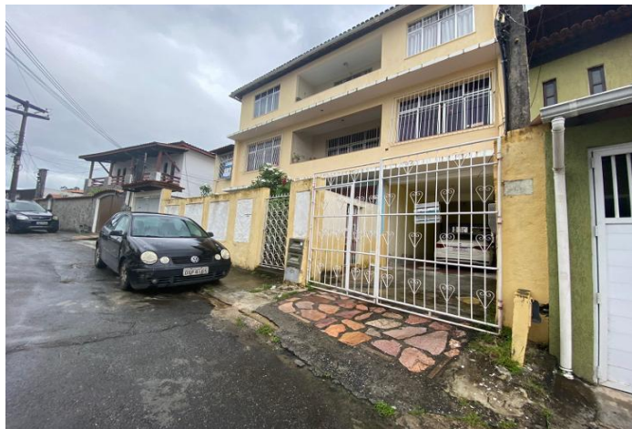
Fachada do avaliando
