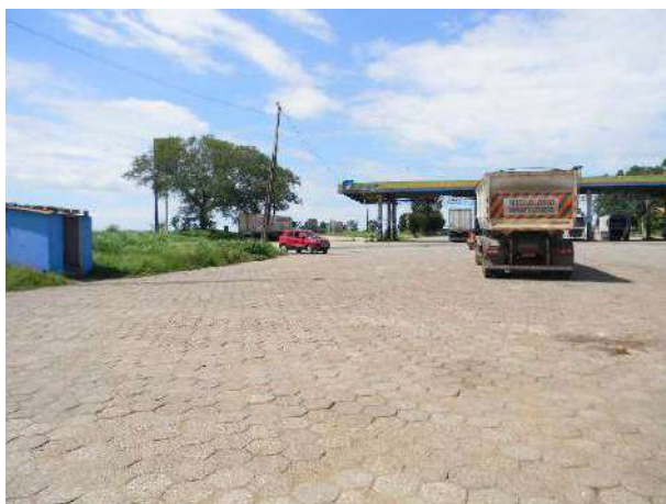
Fotos 4, 5, 6 e 7: Trechos com pavimentação em bloquetes de concreto.
