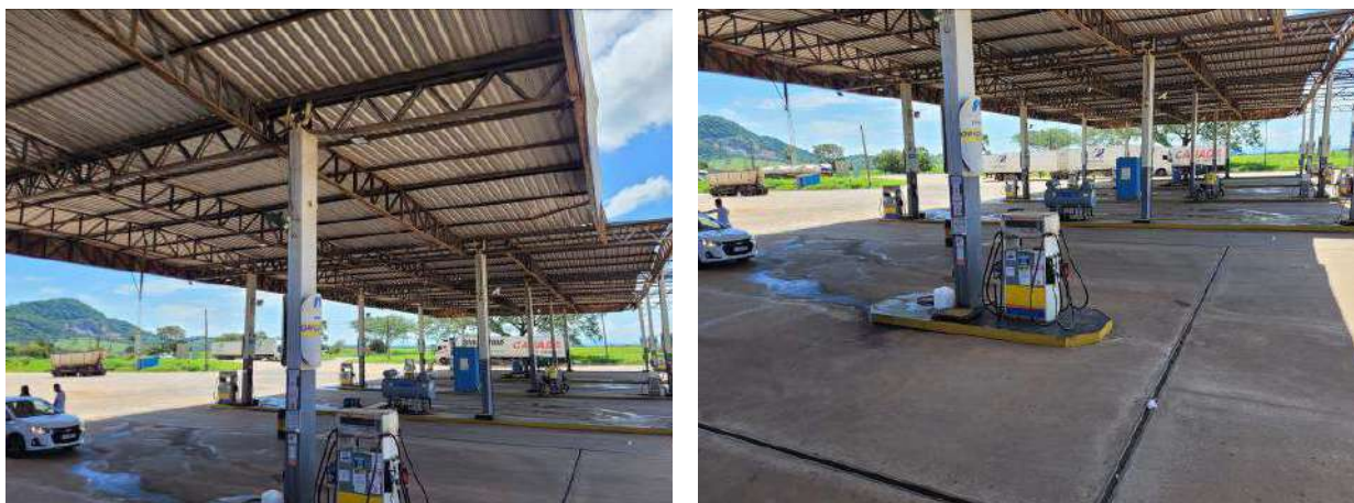
Fotos 8 e 9: Trechos com pavimentação concreto usinado desempenado.
