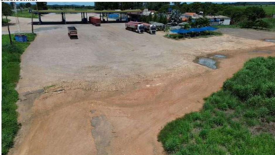
Foto 32: Local do dormitório demolido
