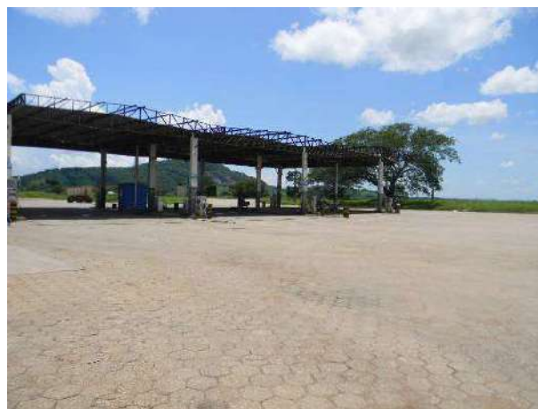
Fotos 4, 5, 6 e 7: Trechos com pavimentação em bloquetes de concreto.
