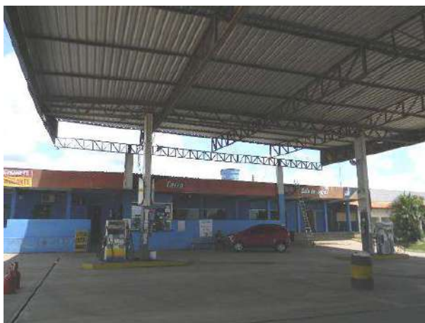
Fotos 33 a 45 : Área administrativa.
