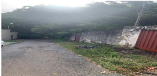
FOTO DA FACHADA. DATA DE 31/03/2025
