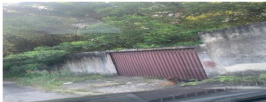
FOTO DA FACHADA. DATA DE 01/04/2025
