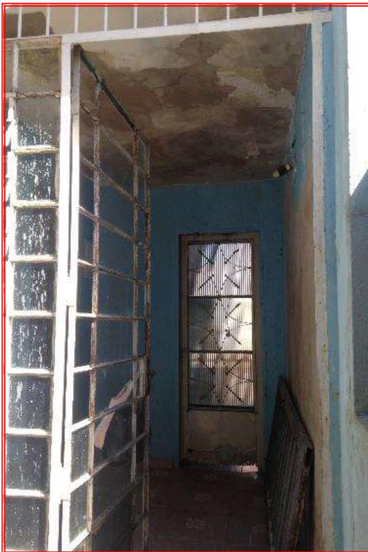
**Foto nº 03:** Vista do hall de entrada, com detalhe para as infiltrações no teto da laje.
