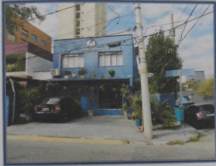
Vista da frente do imóvel avaliando.
