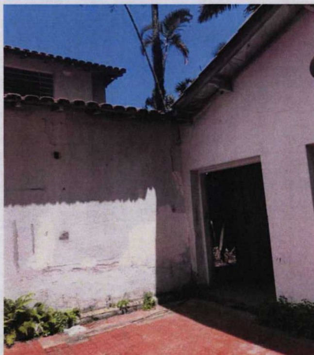
Fundos da construção
