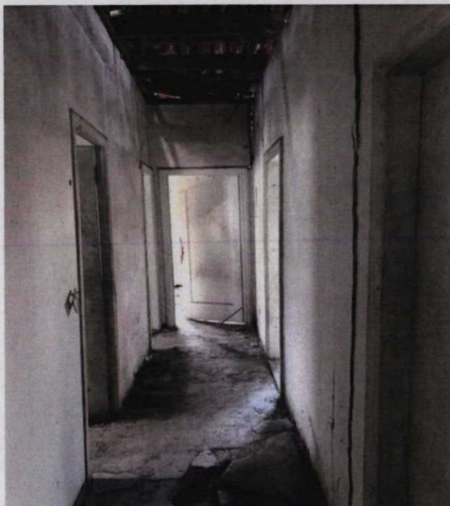
Aspectos da construção
