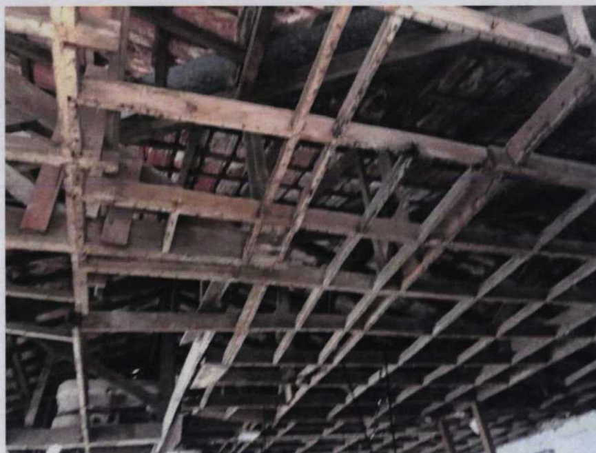
Aspectos da construção
