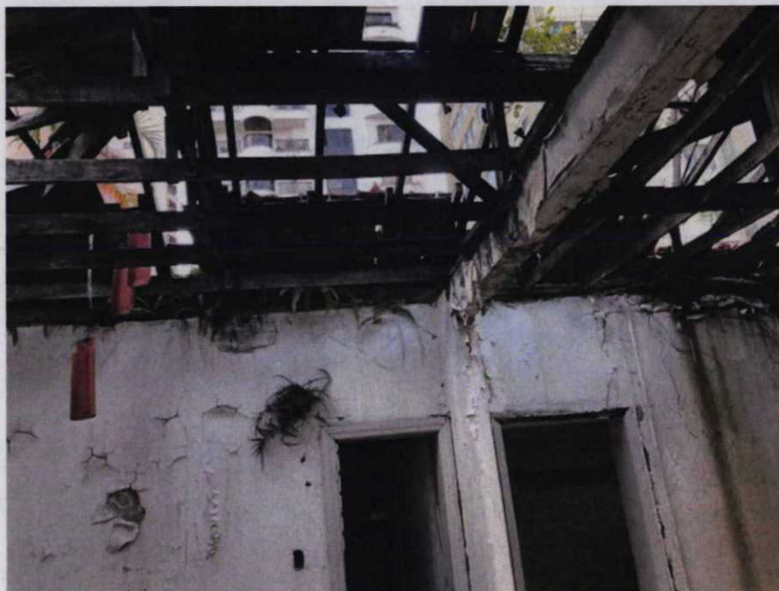
Aspectos da construção
