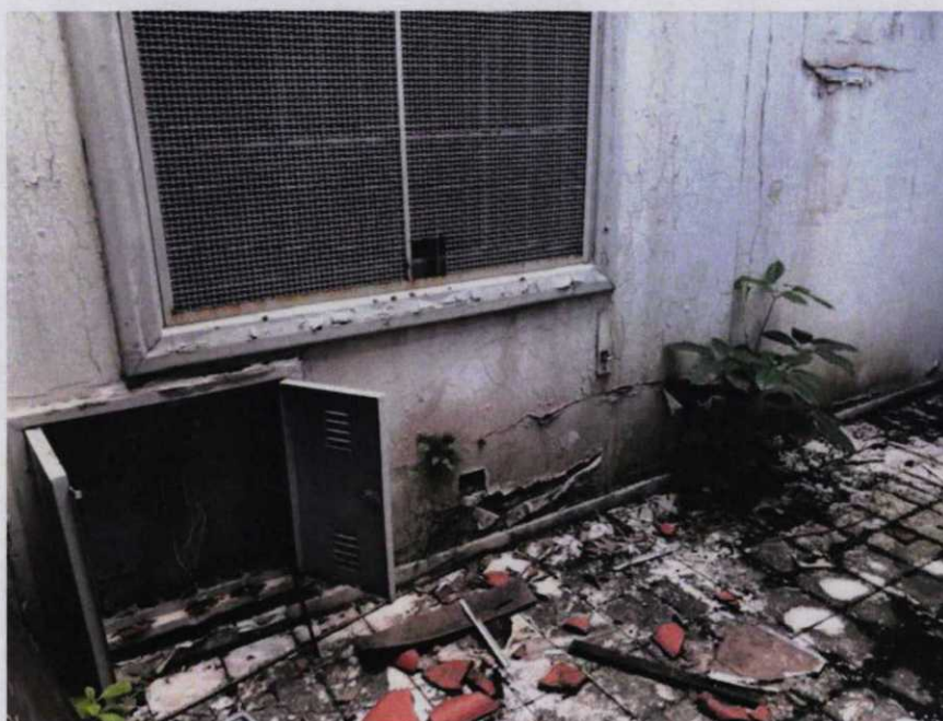
Aspectos da construção
