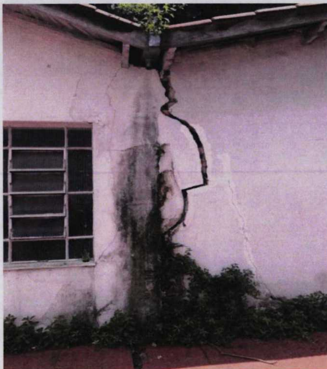
Fundos da construção
