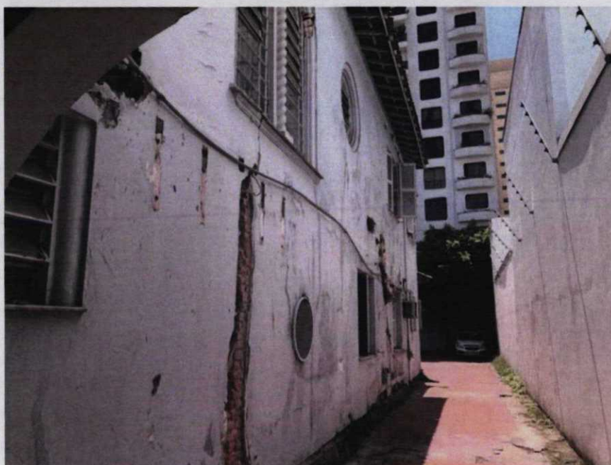
Vista lateral da construção
