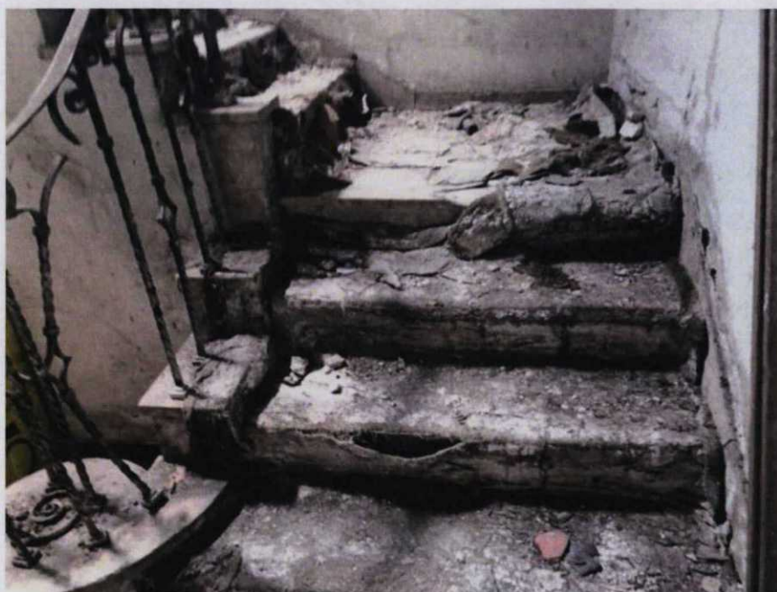
Estado da escada e paredes
