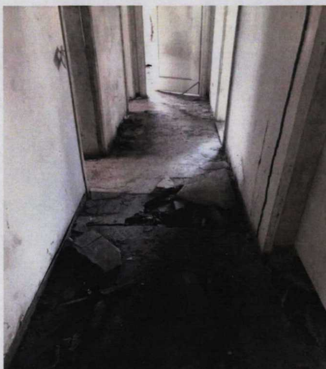
Aspectos da construção
