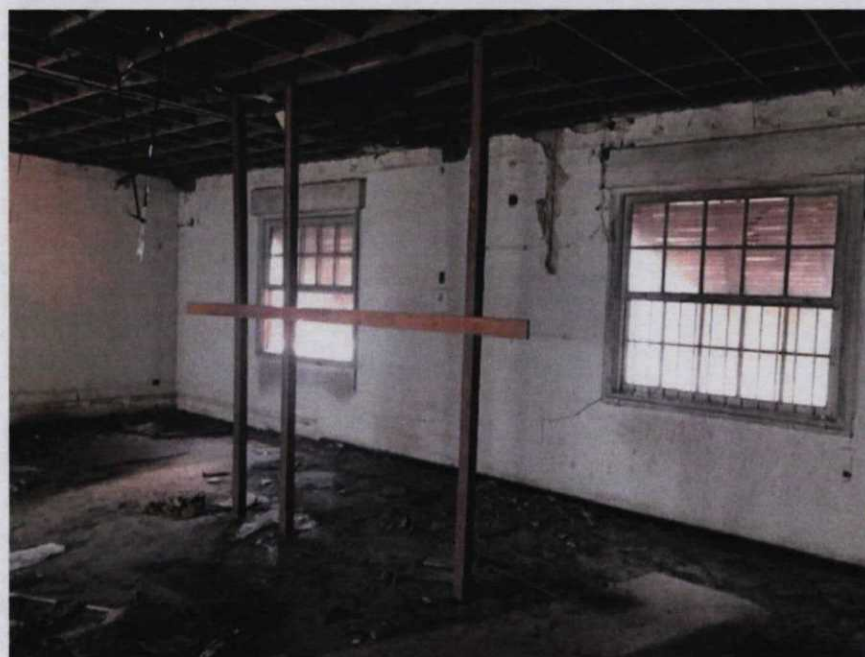
Aspectos da construção
