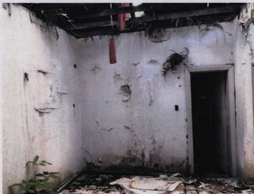
Aspectos da construção
