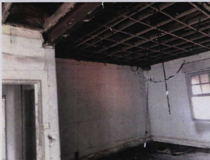
Aspectos da construção
