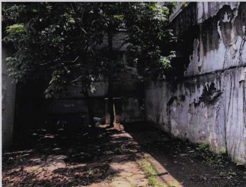
Fundos da construção
