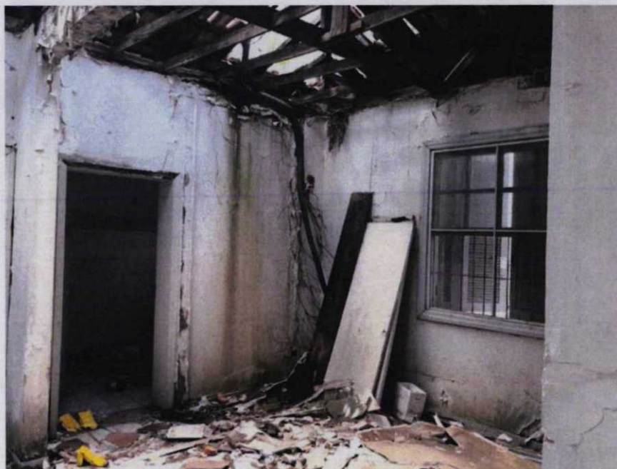
Aspectos da construção
