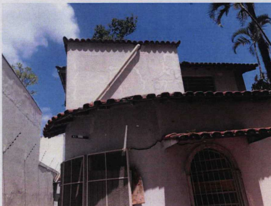
Fundos da construção
