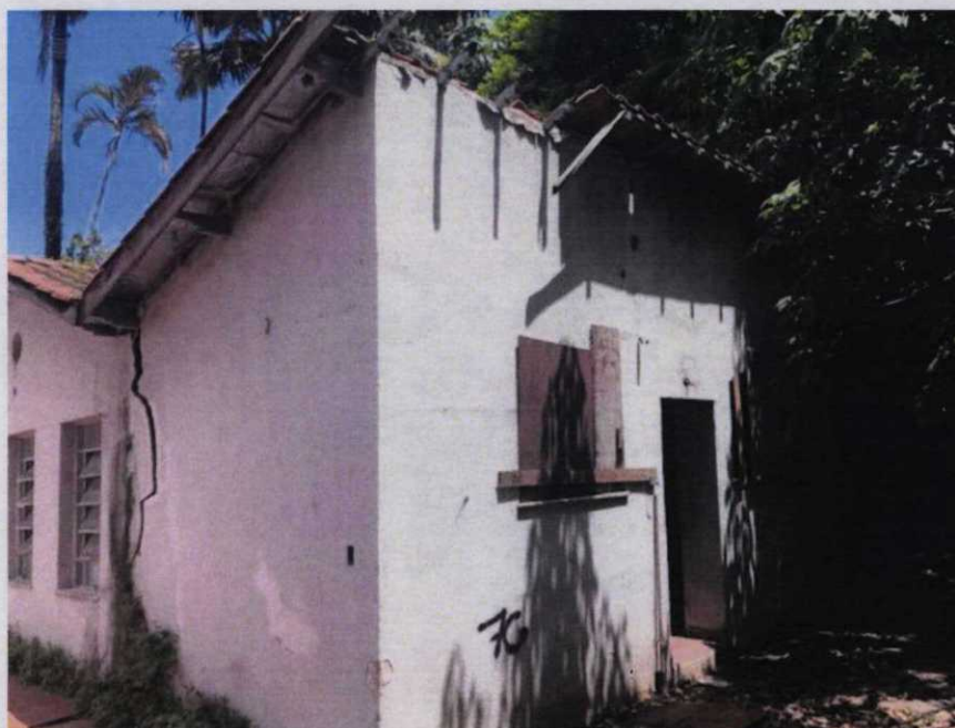
Fundos da construção
