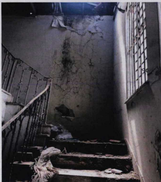
Estado da escada e paredes
