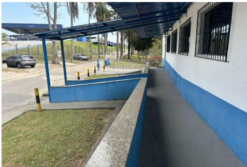
FOTO 6. Vista para entrada do imóvel.
