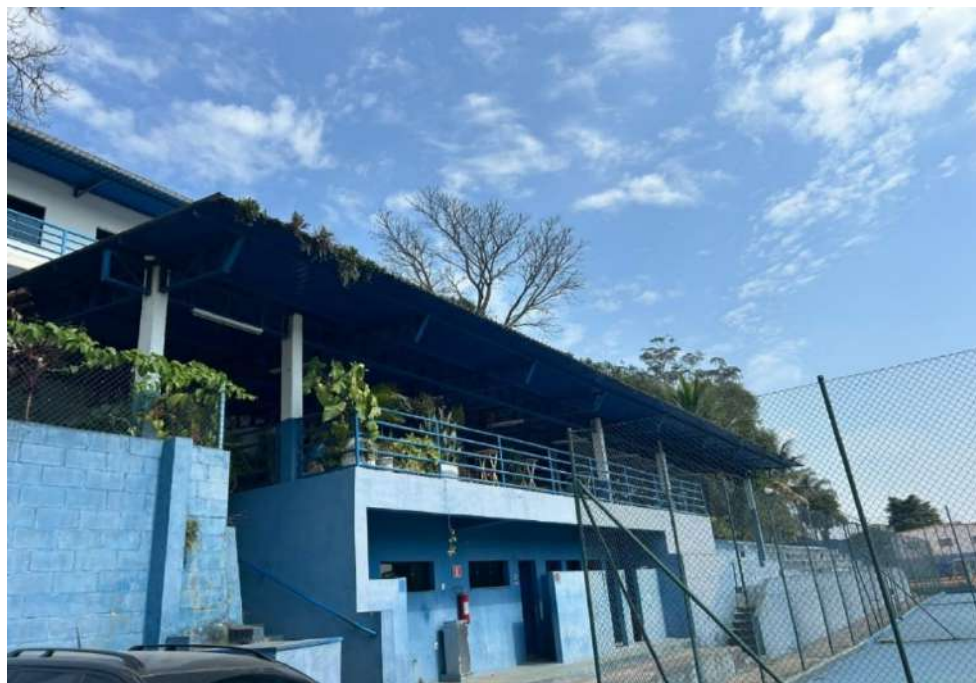
FOTO 5. Vista geral para o imóvel.
