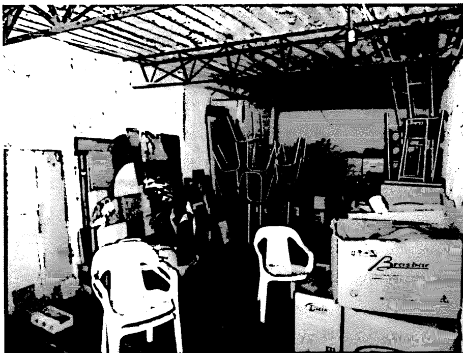
FOTO Nº 08: Ilustração geral da cobertura inserida no segmento posterior do terreno.
