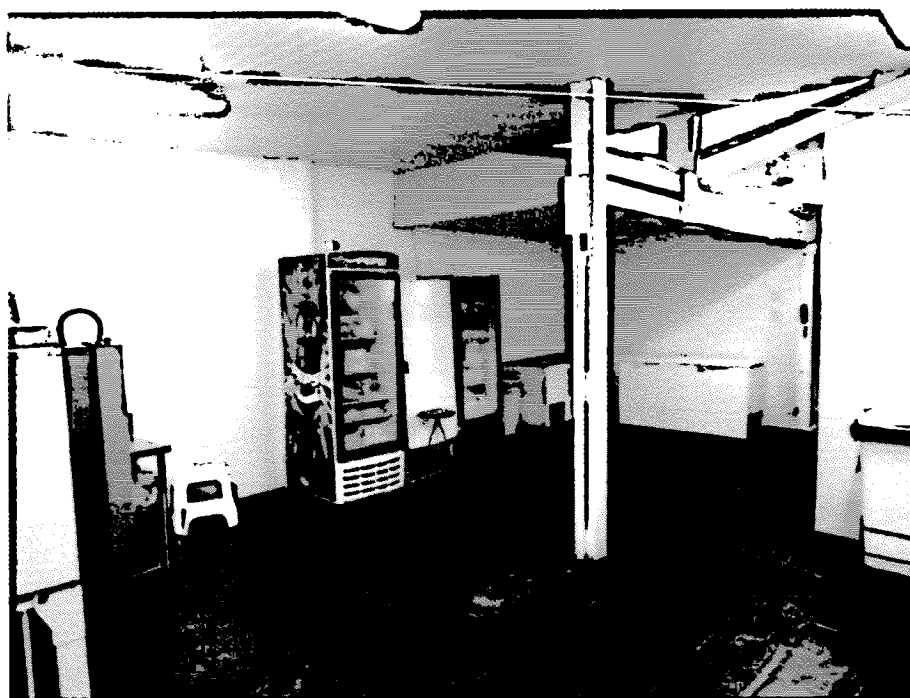
FOTO Nº 05: Ilustração parcial da sala 5, situada no segmento posterior do imóvel.
