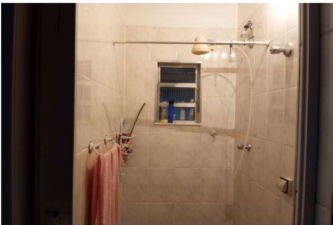
FOTO nº 07 Vista do banheiro I.
