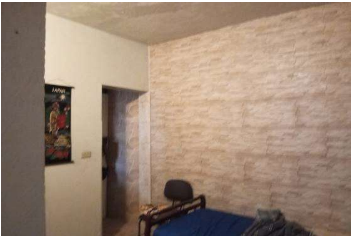
FOTO nº 08 Vista do dormitório I.
