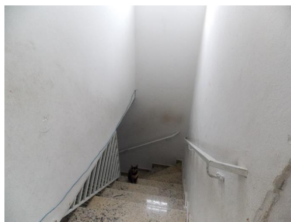
Foto 8 – Escada de acesso ao pavimento superior.
