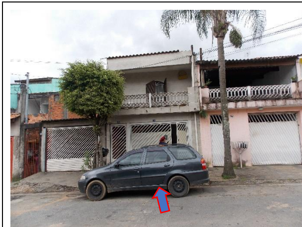
Foto 1 – Identificando o imóvel, situado na Rua Geraldo Augusto da Silva, 634.
