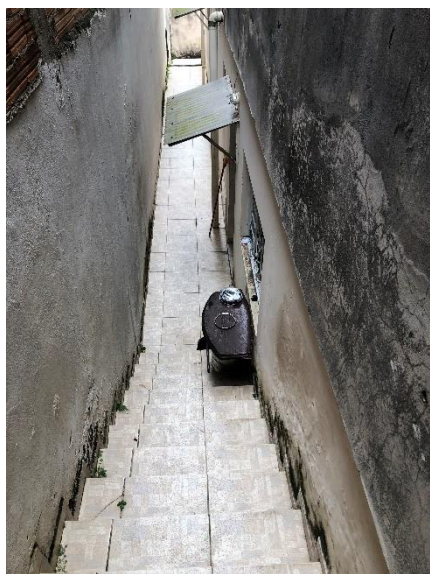
Foto 15 – Acesso ao pavimento inferior.
