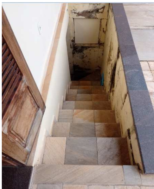
Acesso ao pavimento inferior.
