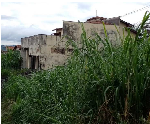
Vista lateral imóvel avaliando – cercado por terrenos baldios.
