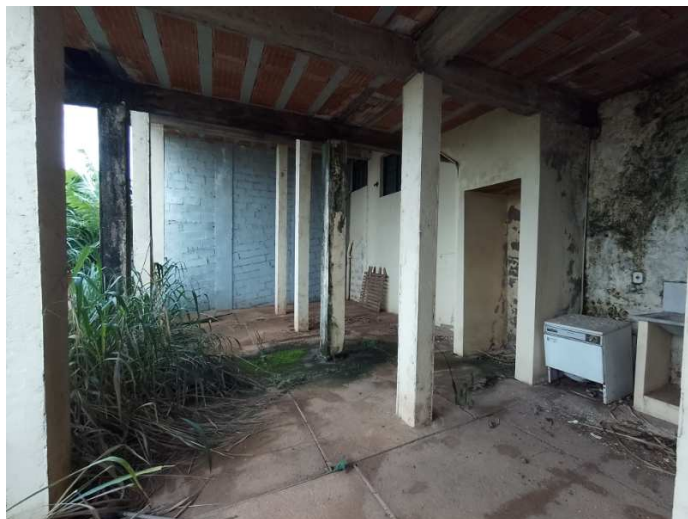
Dependências externas – pavimento inferior.
