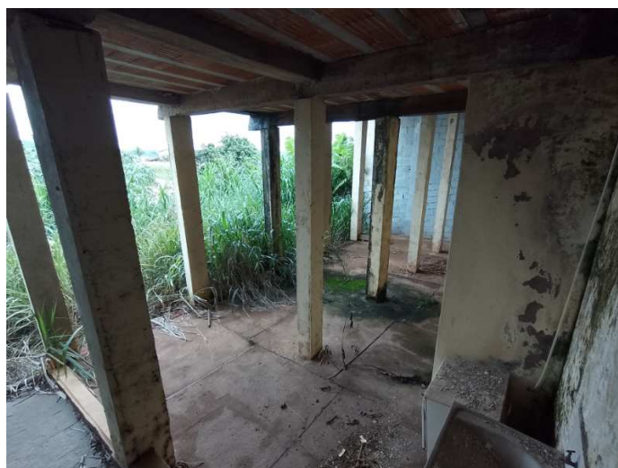
Dependências externas – pavimento inferior.
