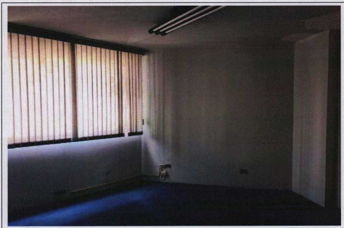
Foto 10: Vista de mais uma sala. Suas principais características construtivas são: piso em carpete, paredes revestidas em massa corrida pintadas em látex, forro em gesso e esquadrias de alumínio.
