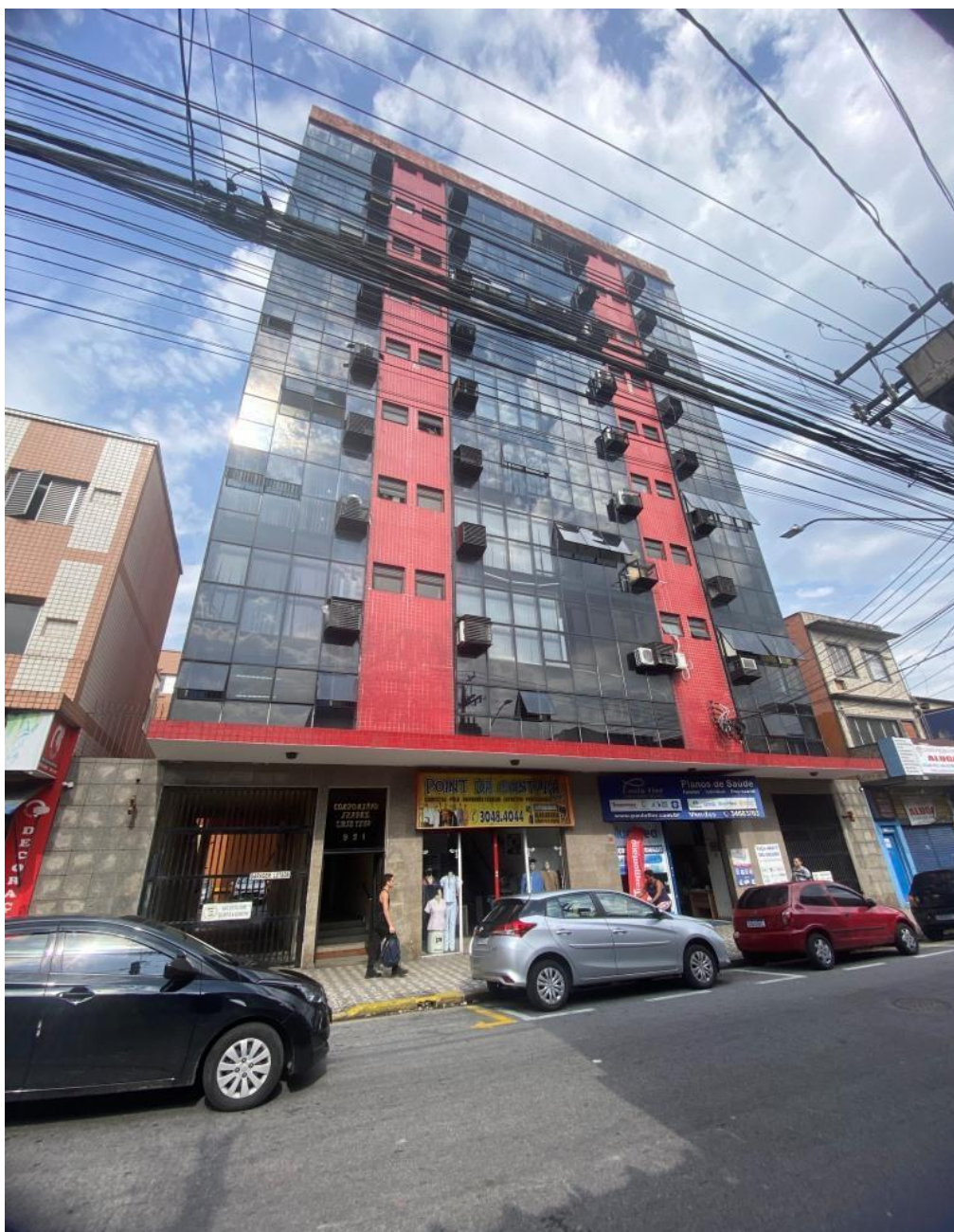
Foto 1 - Fachada do Edifício ISABEL CRISTINA
