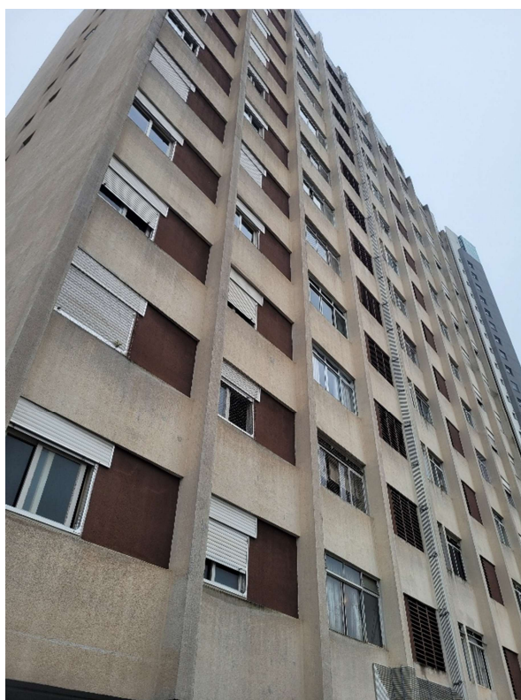
FOTO 02 – FACHADA DO EDIFÍCIO
