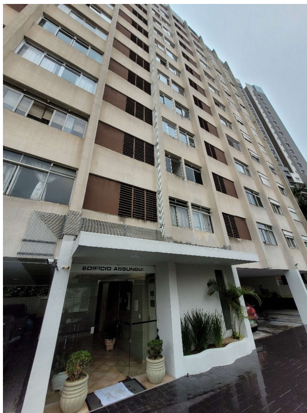
FOTO 03 – ENTRADA DO PRÉDIO
