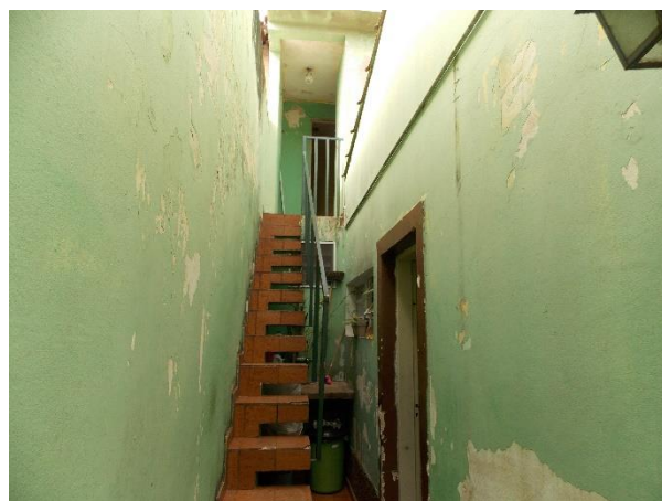
Foto 14 – Escada de acesso ao pavimento superior.
