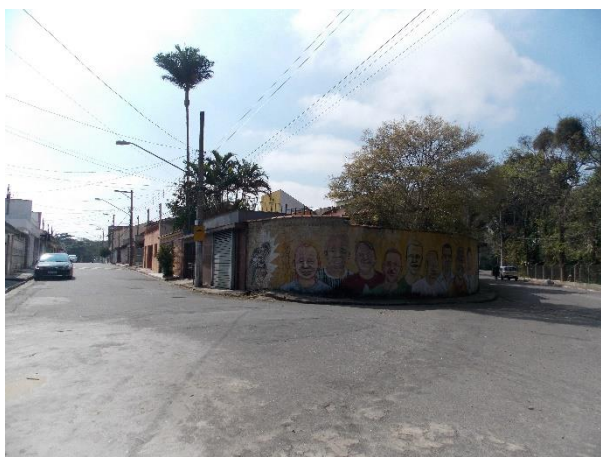
Foto 3 – Aspecto geral do Imóvel Rua Osasco esquina Rua Máximo Gonçalves.
