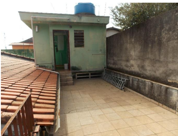
Foto 15- Pavimento superior – Área livre e lavanderia.
