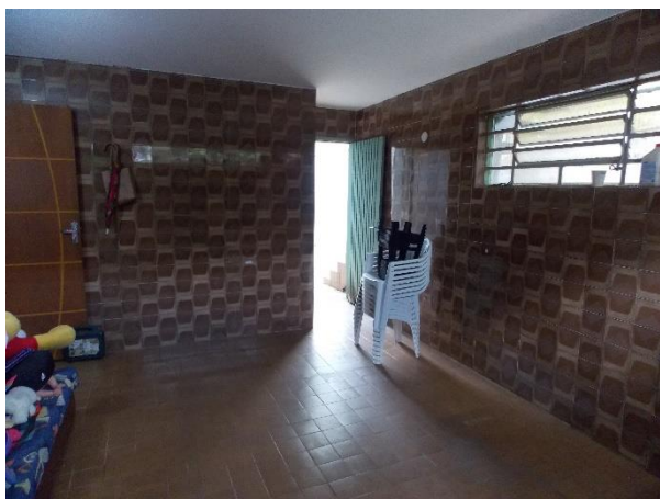
Foto 5 – Outra garagem coberta.
