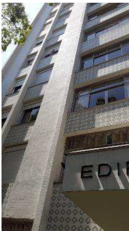
Foto nº 3 – Fachada frontal do imóvel. Lado esquerdo.
