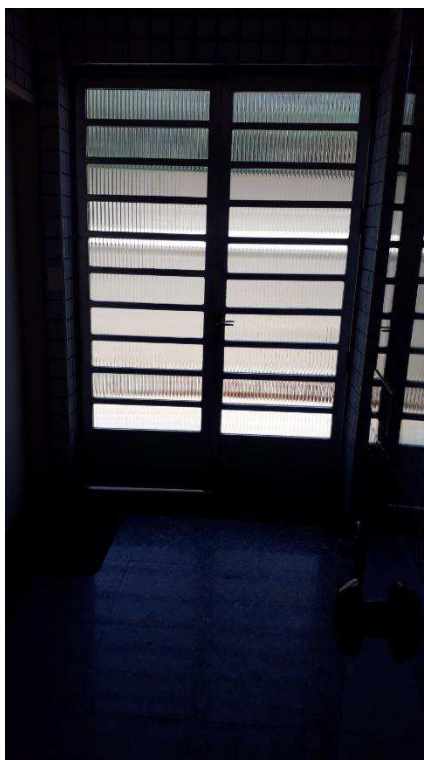
Foto nº 13 – Área de circulação comum – Porta de Entrada.
