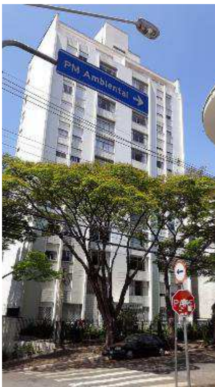
Foto nº 1 – Fachada frontal do imóvel.
