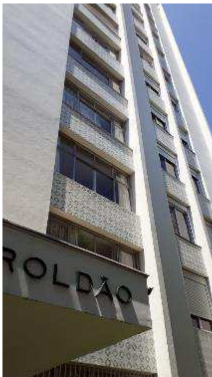
Foto nº 4 – Fachada frontal do imóvel. Lado direito.
