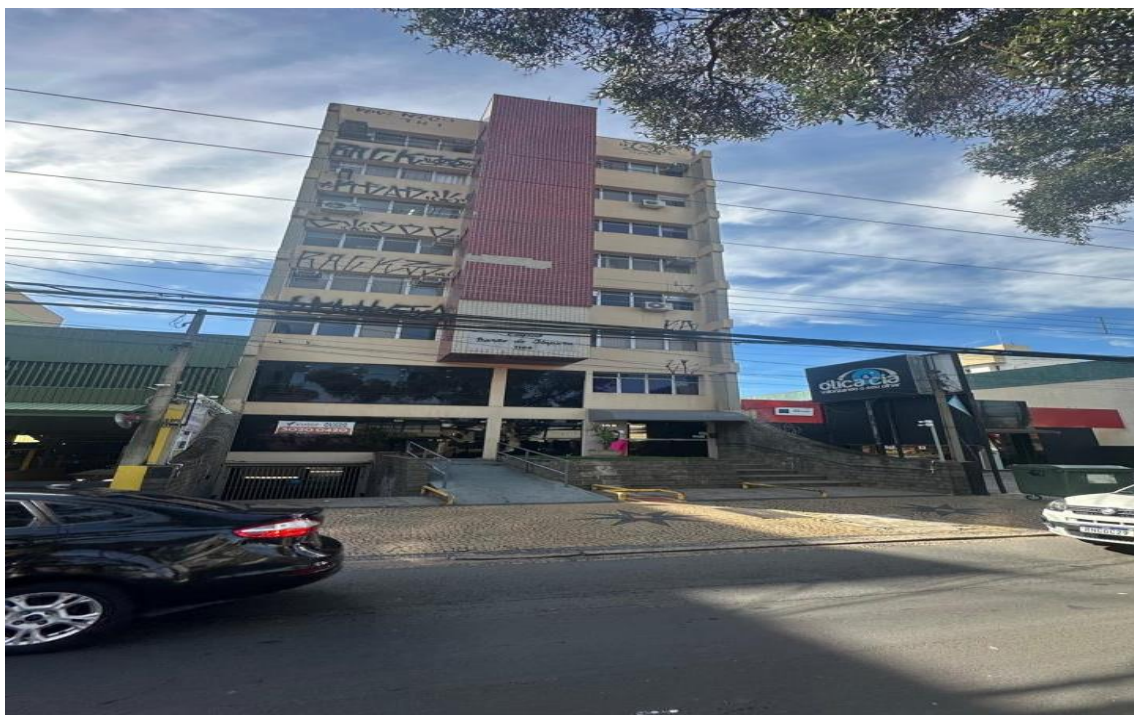
Frente do edifício
