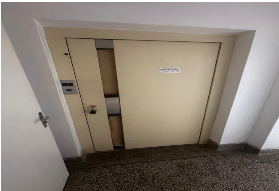
Elevador com acesso privativo
