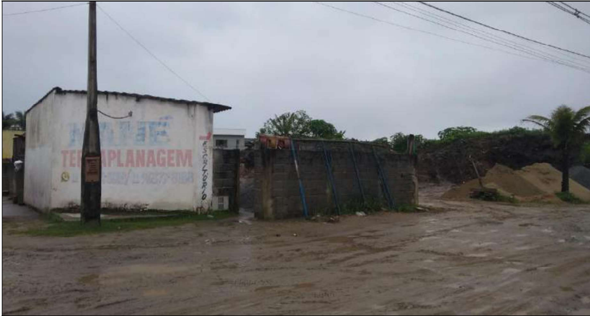
Foto 1 - Vista da Fachada dos Imóveis Avaliando
