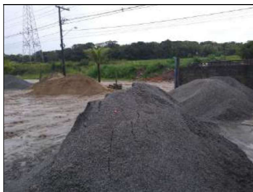
Foto 9 - Vista do lote 8 para a avenida
