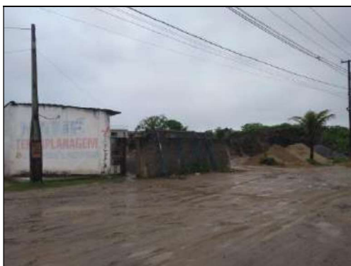
Foto 2 – Fachada, vista do lote 8 para o lote 5
