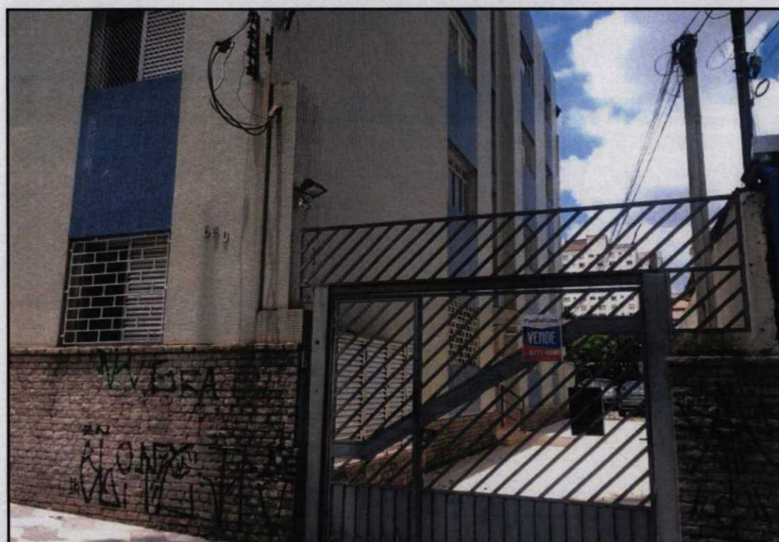
Foto 2 : Entrada do edifício
