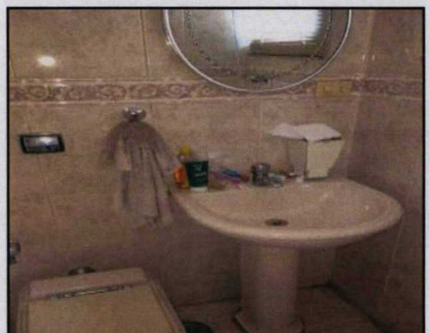
Foto 11 : Banheiro da suíte
