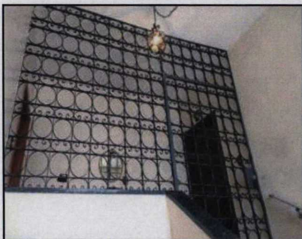
Foto 6 : Acesso ao imóvel avaliando – apto 8
