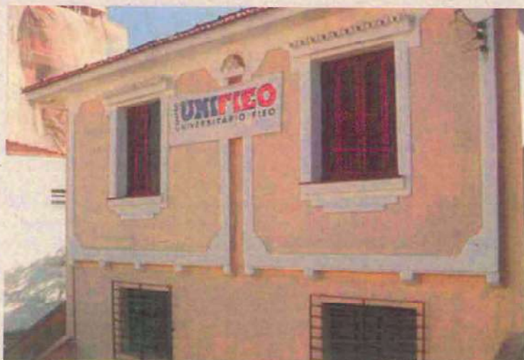
FOTO 4 – Vista da fachada frontal e lateral.
