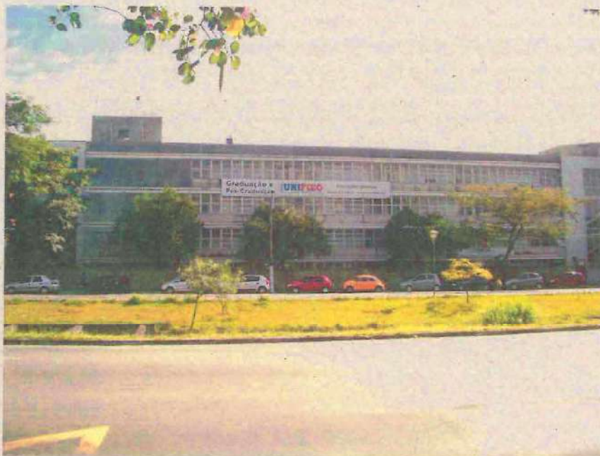
FOTO 3 – Vista da Fachada do campus a partir da Rua Narciso Sturlini.
