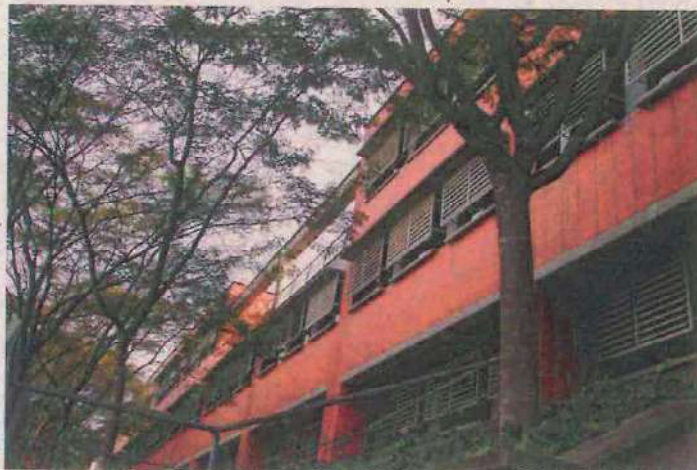
FOTO 1 – Vista geral da fachada do prédio principal.
