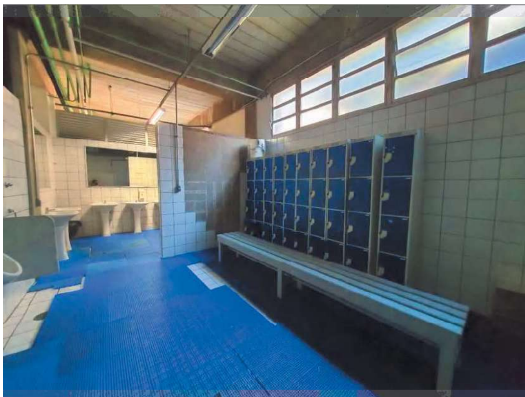
Subsolo da Quadra de Esportes – vestiário
