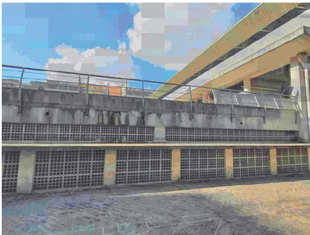
Área externa – conservação
