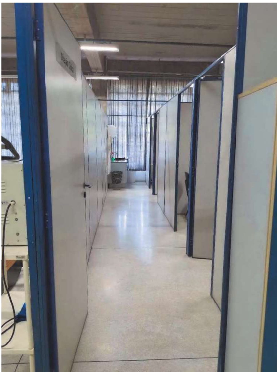
Subsolo da Quadra de Esportes
