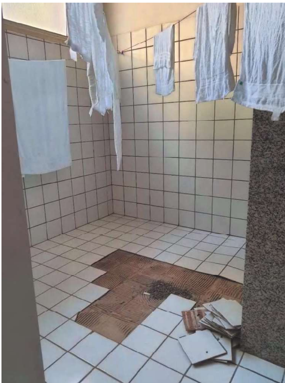
Ginásio de esportes – vestiário
