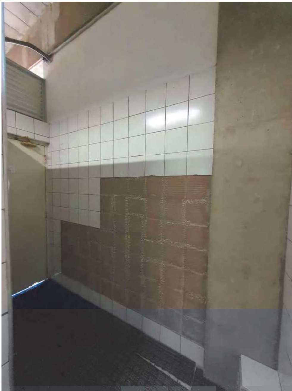
Subsolo da Quadra de Esportes – vestiário
