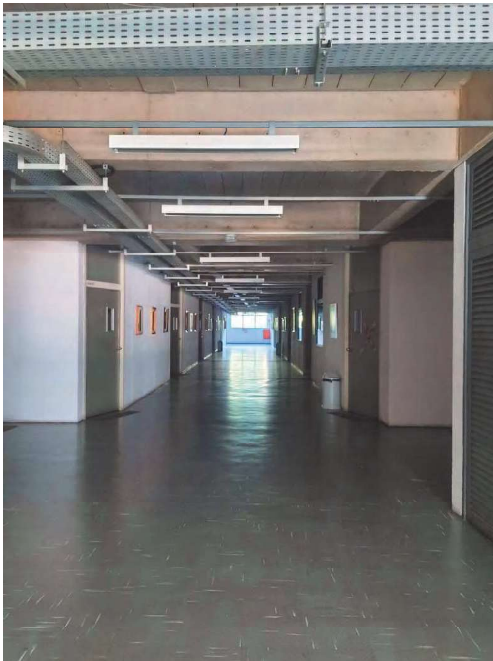
Bloco Prata – 1º subsolo salas de aula
