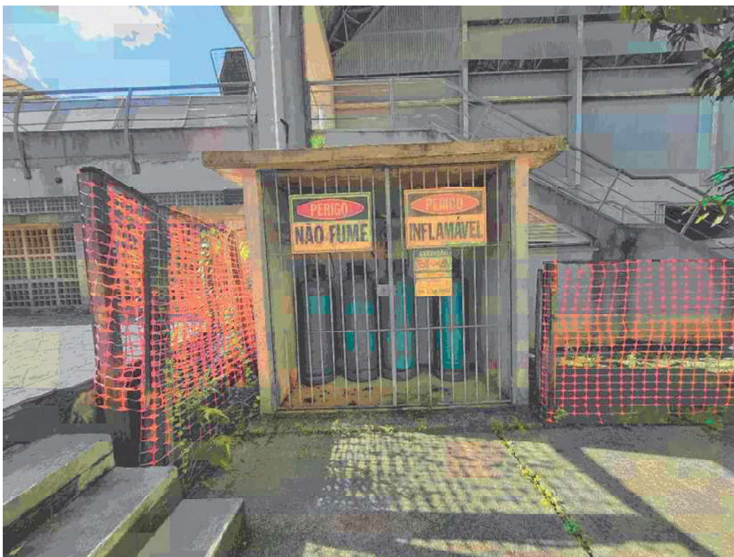
Área externa – conservação
