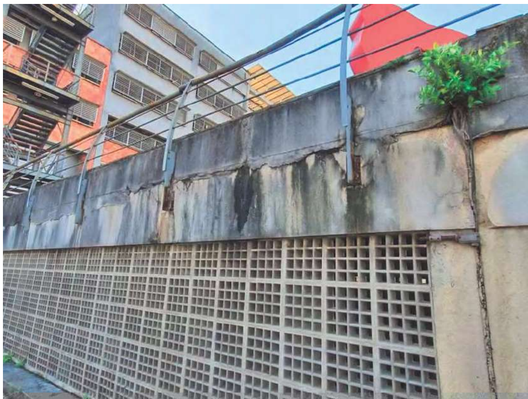
Área externa – conservação
