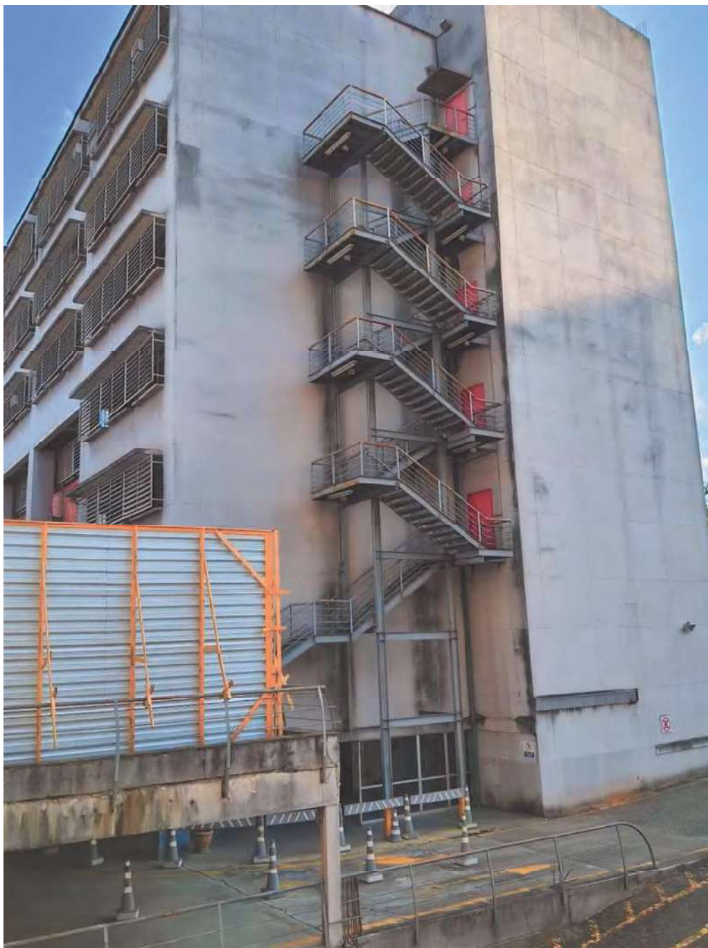
Bloco Branco – lateral de acesso ao estacionamento
