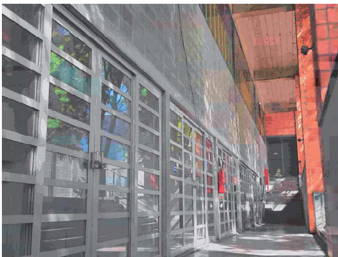
Prédio principal - corredor externo / Box
