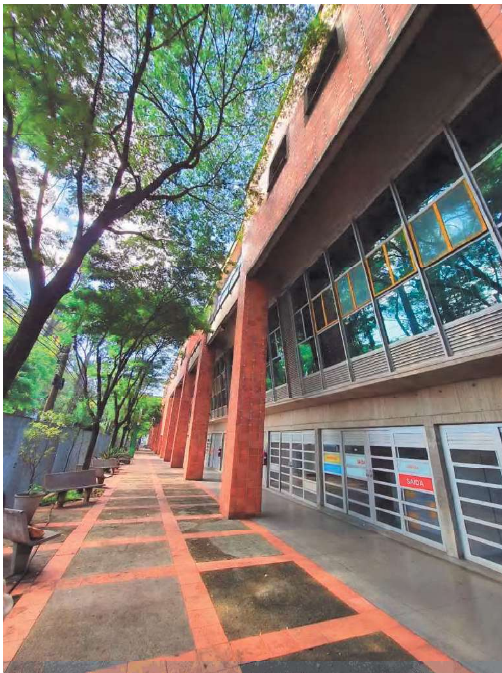
Prédio principal - corredor externo / Box
