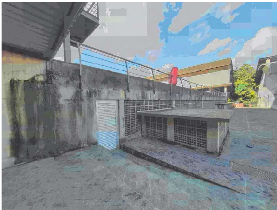
Área externa – conservação
