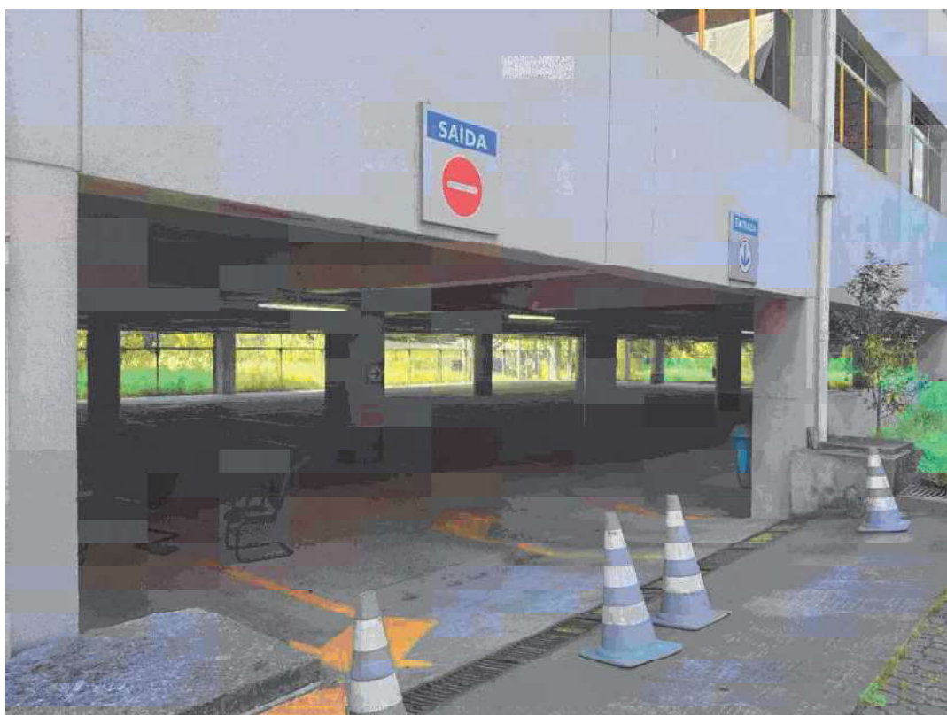
Estacionamento inferior – Bloco Prata
