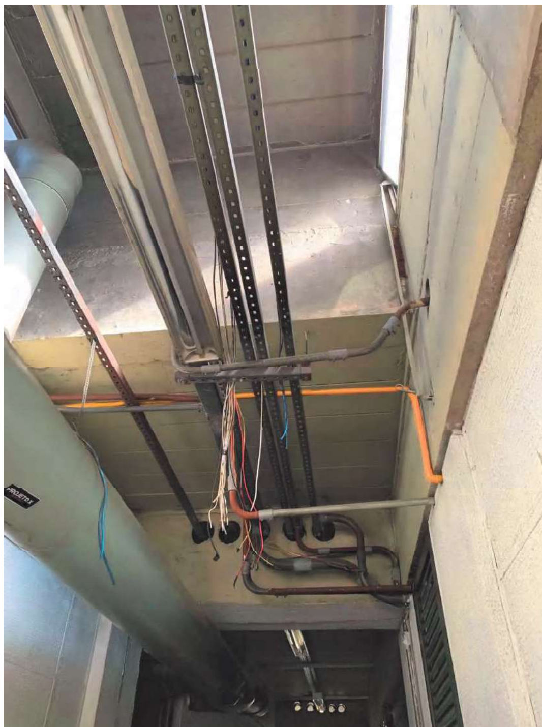
Instalações elétricas – estrutura e conservação
