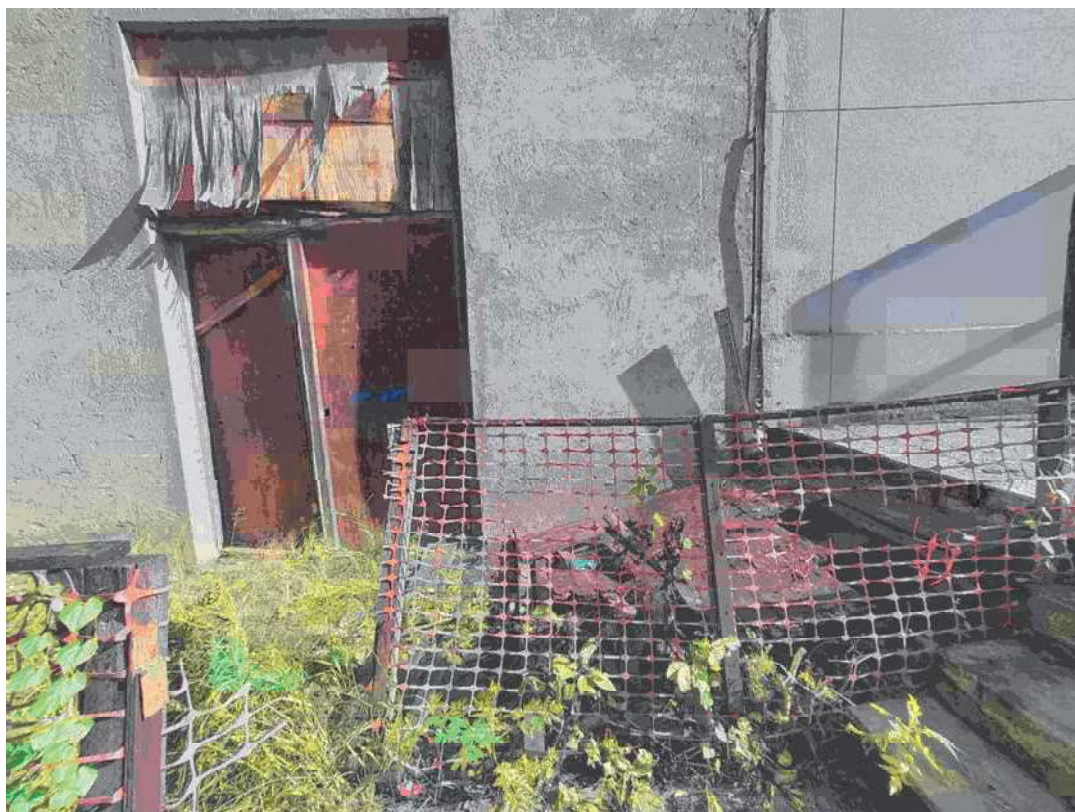
Área externa – conservação
