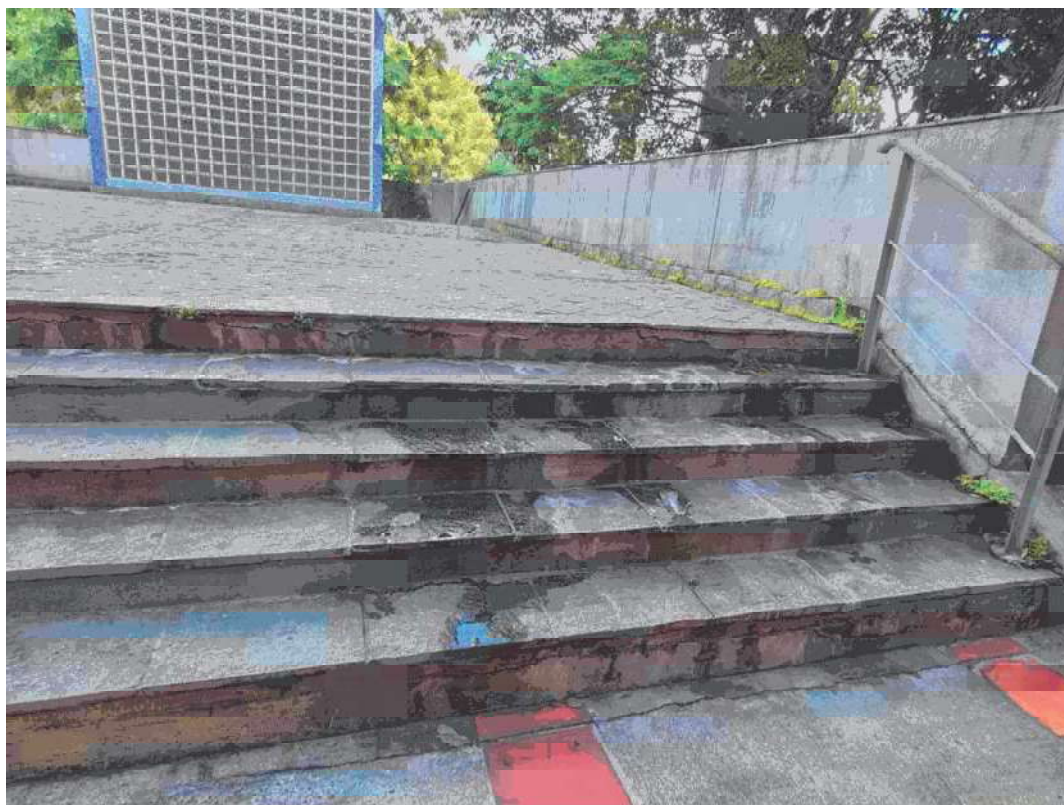
Área externa – conservação
