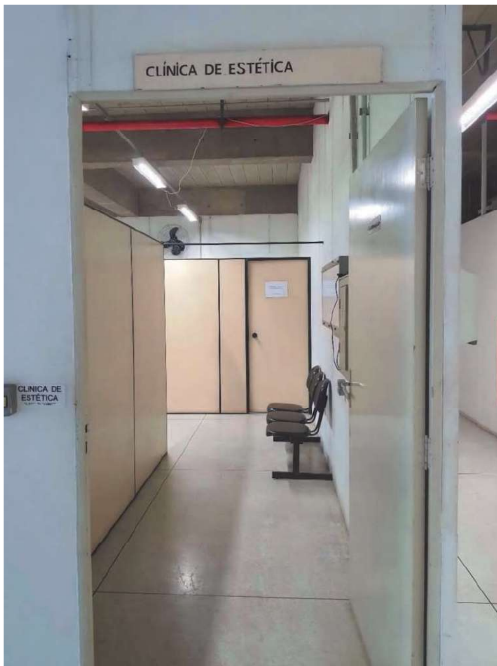
Subsolo da Quadra de Esportes
