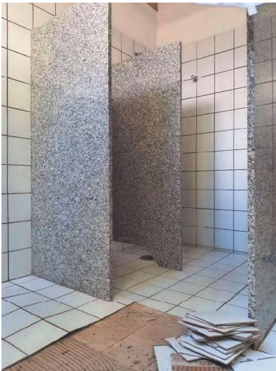
Ginásio de esportes – vestiário
