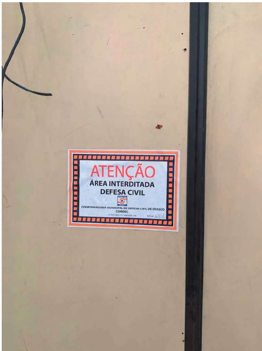
Parte da área interna interditada / inacessível
