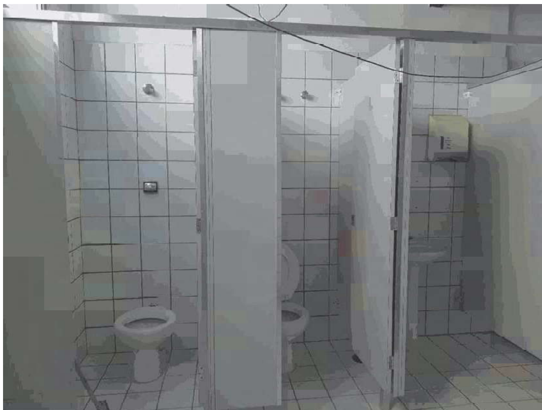
Ginásio de esportes – vestiário
