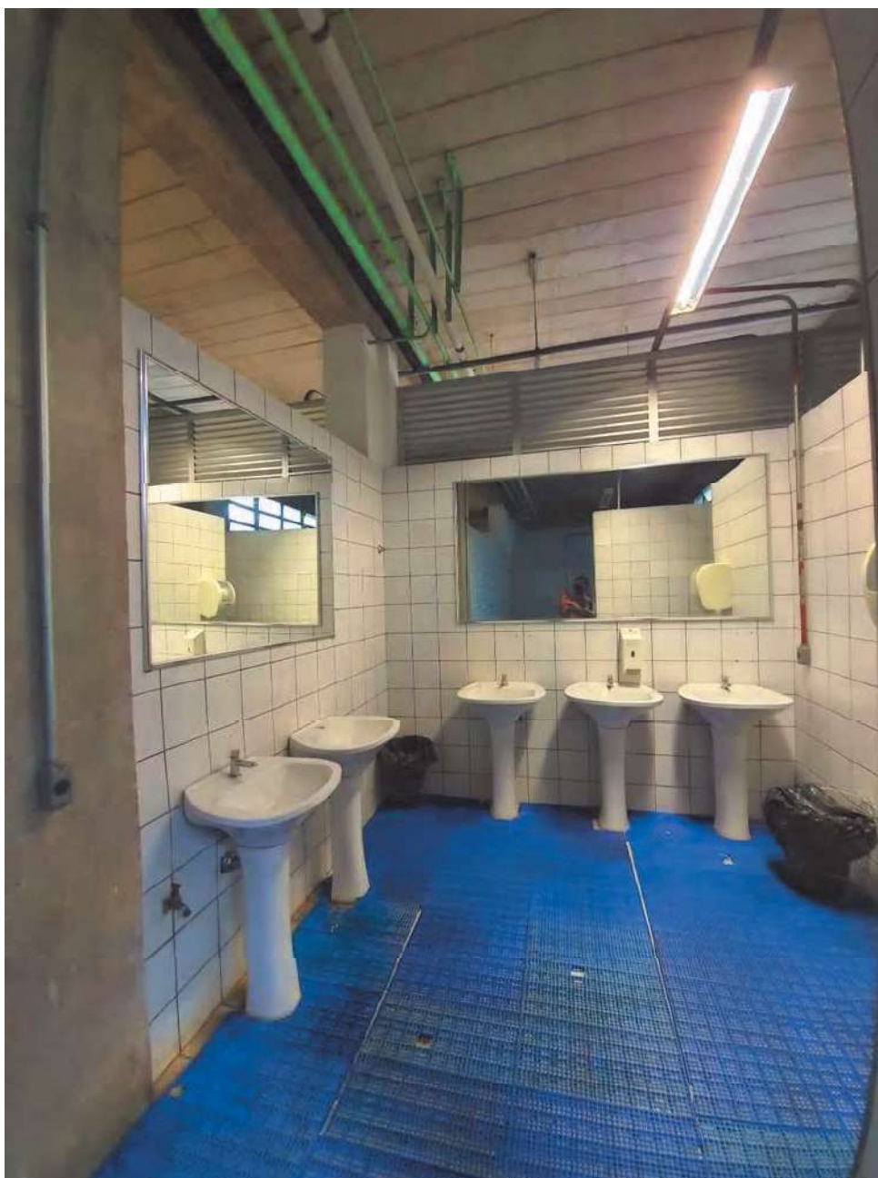
Subsolo da Quadra de Esportes – vestiário
