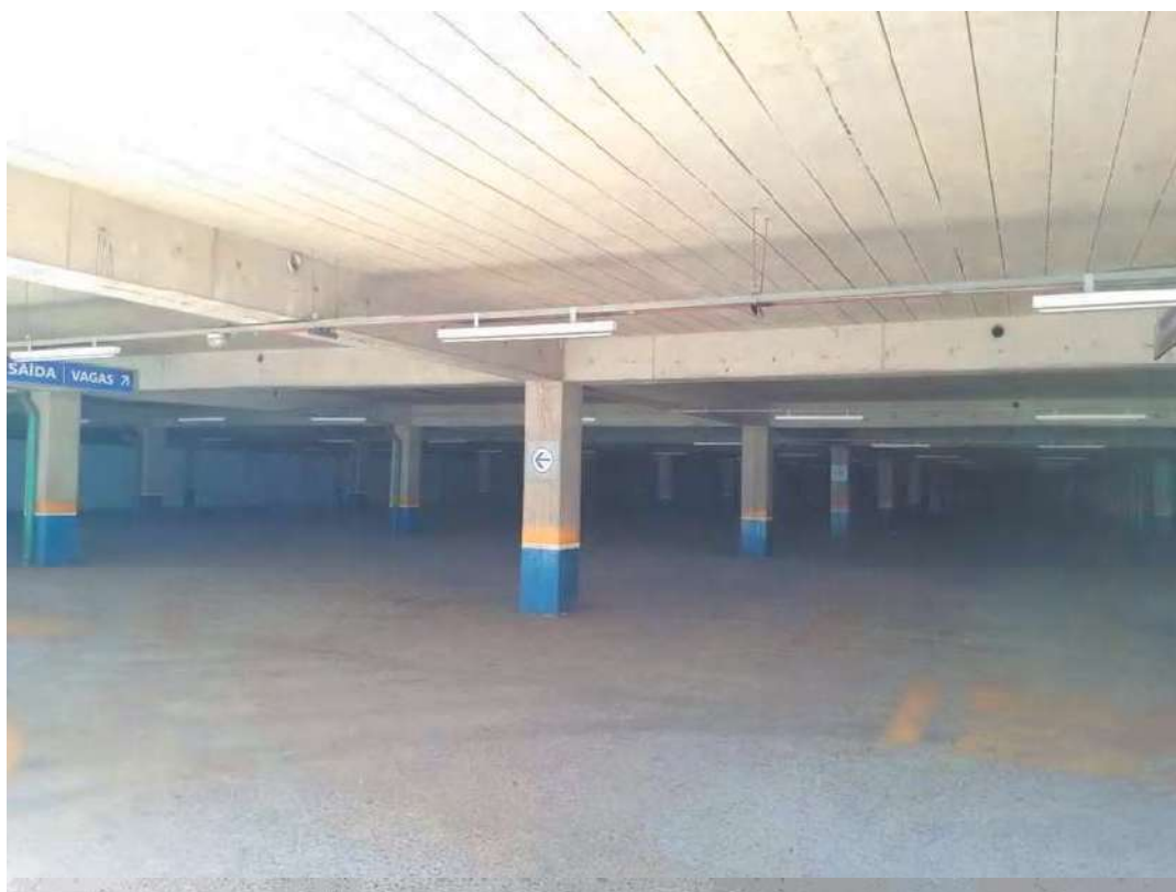
Estacionamento inferior – Bloco Branco
