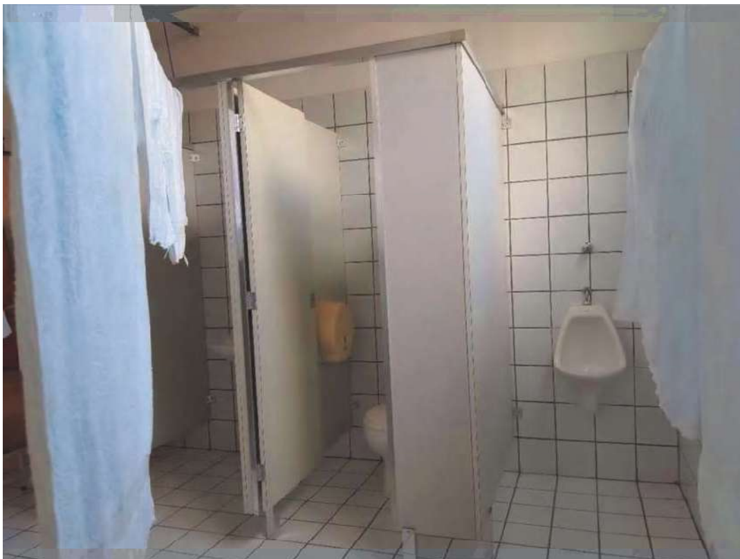
Ginásio de esportes – vestiário
