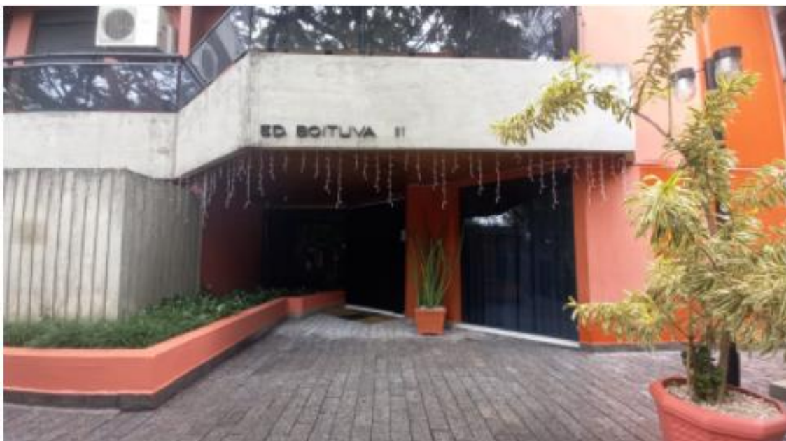
Foto 04. Entrada da área social do Ed. Boituva
