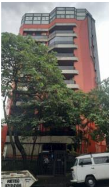
Foto 02. Fachada Ed. Boituva
