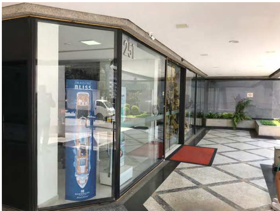
Foto 5- Entrada (Térreo)do Edifício de escritórios.
