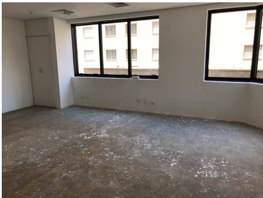
Foto 10- Salão do conjunto c/ janelas para a lateral do prédio
