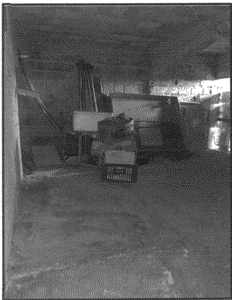
Pavimento inferior 2 – Casa 4 Quarto, sala e cozinha (em fase de construção)
