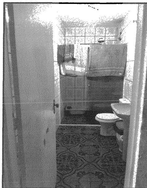
Pavimento inferior 1 – Casa 2 – Banheiro
