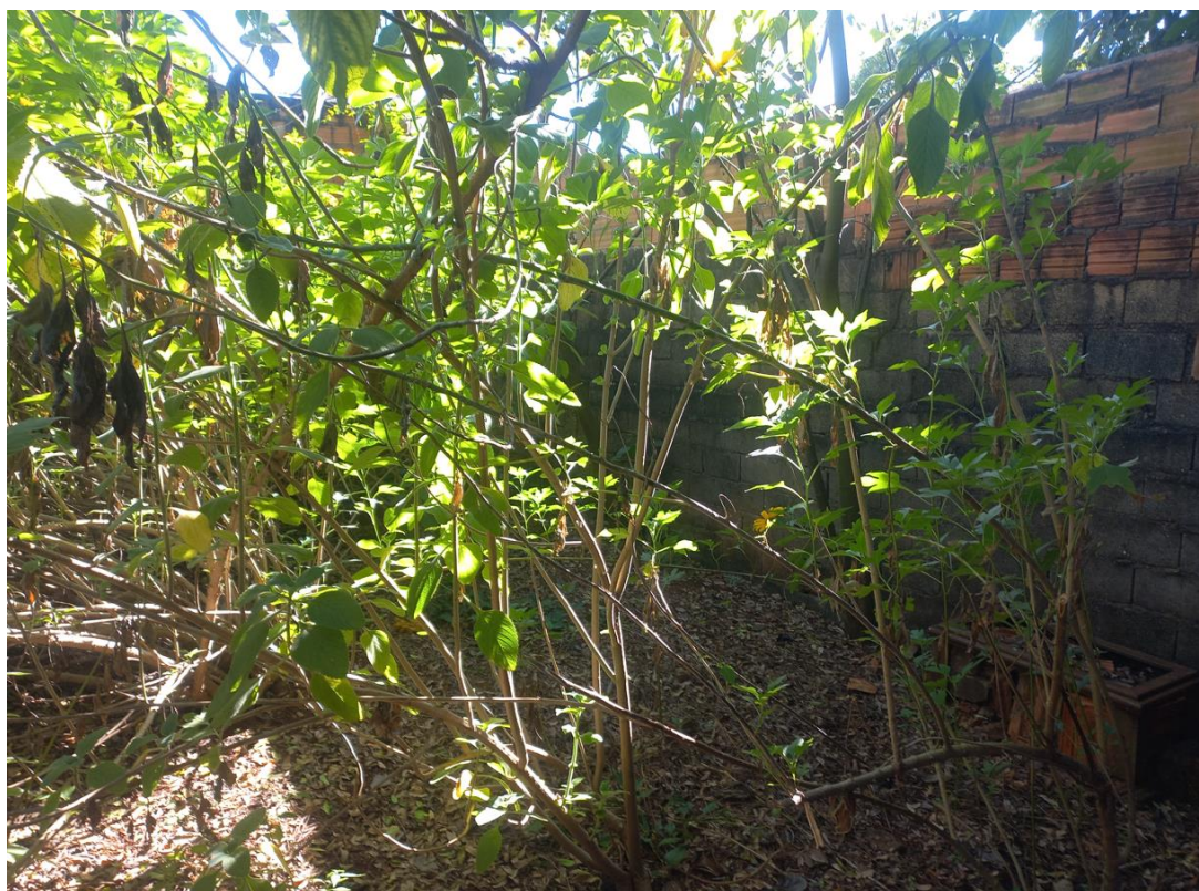
Foto 13: Muro dos fundos do terreno e detalhe da vegetação
