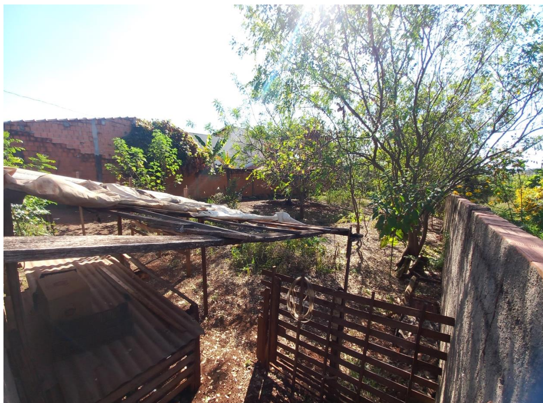
Foto 9: Muro de divisa à direita e detalhe da vegetação
