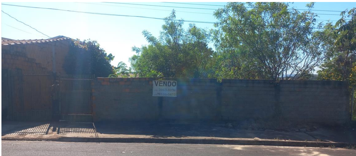
Imagem 1: Fachada do terreno do imóvel avaliando, muro frontal de divisa.
