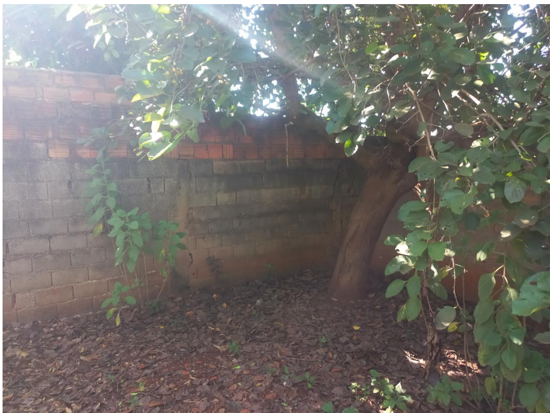
Foto 12: Muro dos fundos do terreno e detalhe da vegetação
