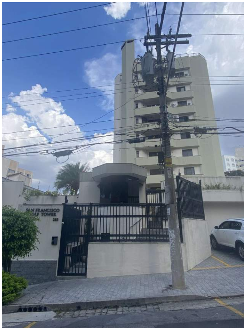
ASPECTOS GERAS FACHADA EDIFICIO
