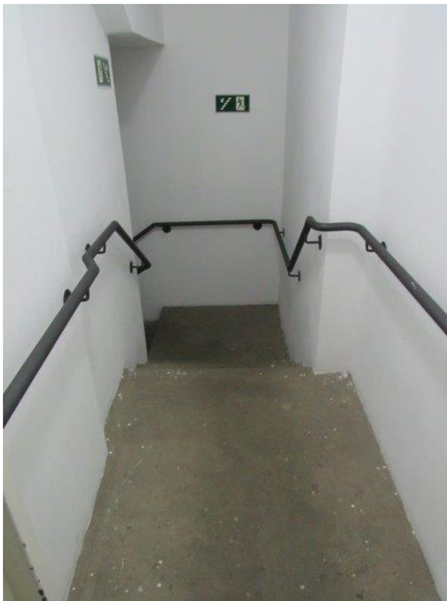
Foto 3 – Vista da escada de emergência do edifício do imóvel avaliando.
