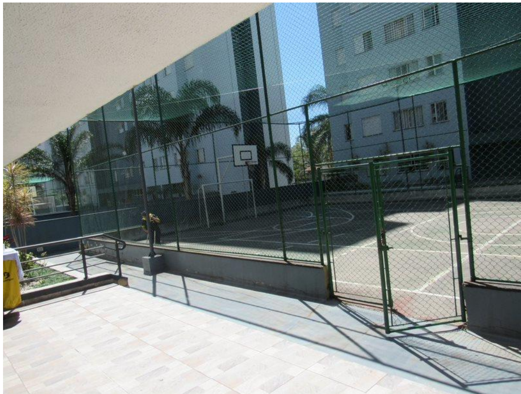
Foto 4 – Vista da quadra poliesportiva do condomínio do imóvel avaliando.
