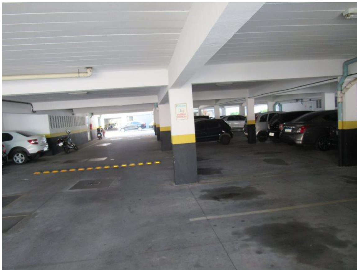
Foto 2 – Vista da garagem do condomínio do imóvel avaliando.
