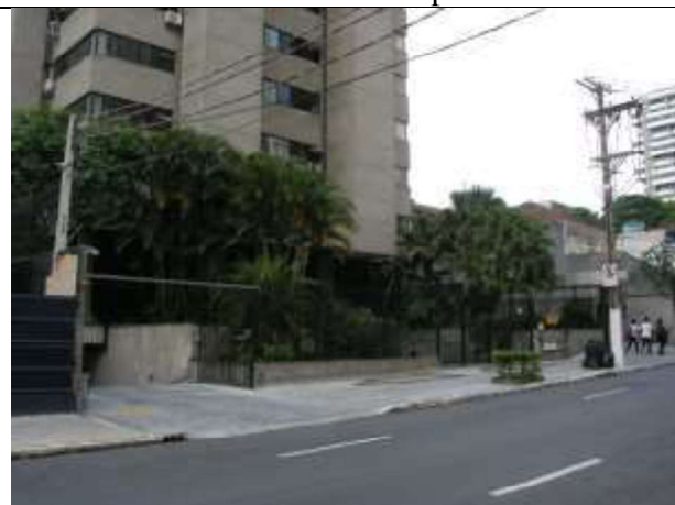
Foto 03 – Vista da frente.
