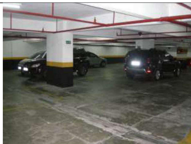
Foto 18 – Garagem do subsolo.
