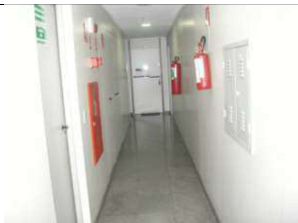
Foto 16 – Corredor no 12.º andar.
