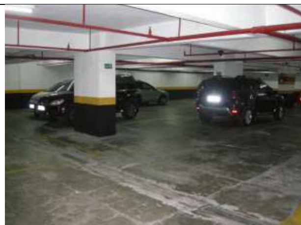
Foto 21 – Garagem no subsolo.
