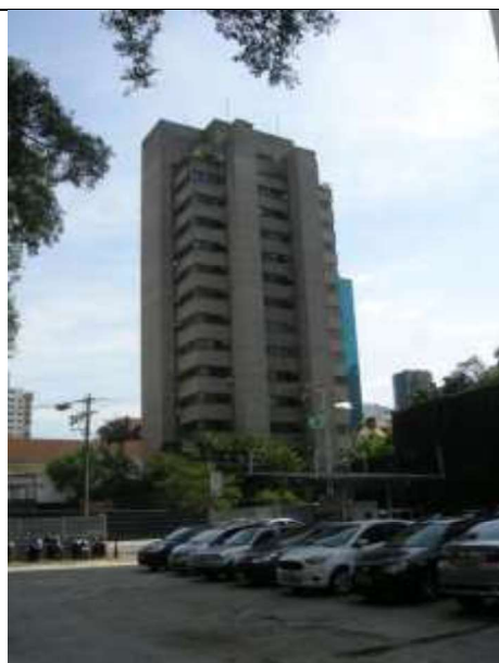
Foto 01 – Vista do prédio.
