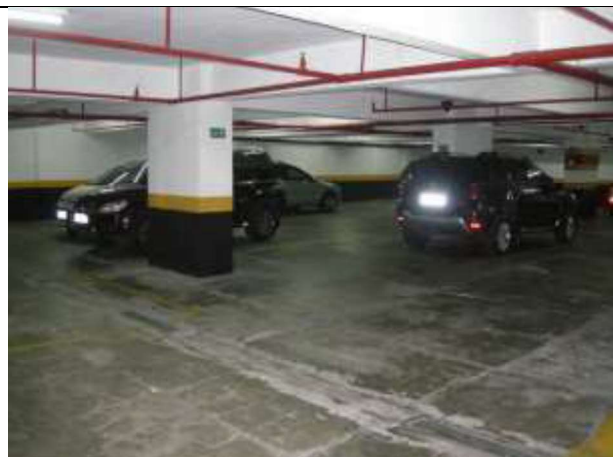
Foto 14 – Garagem no 3.º subsolo.
