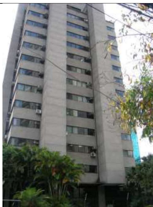
Foto 20 – Outra vista da fachada.
