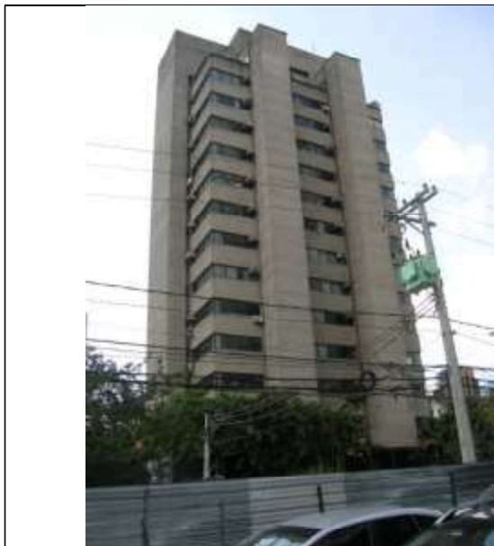
Foto 01 – Vista da fachada principal.
