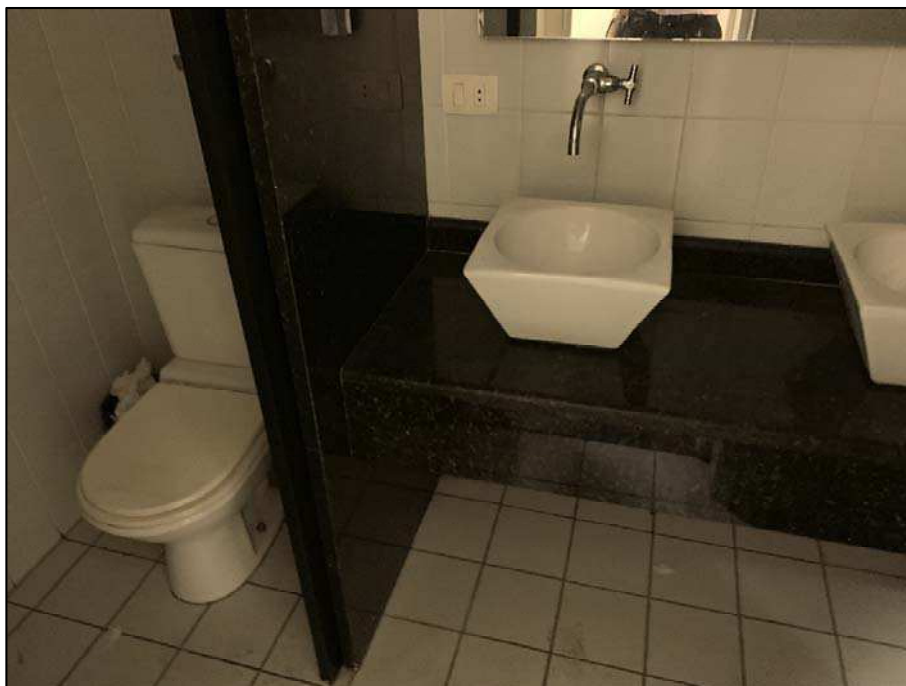
Foto 26. Detalhe do banheiro social do imóvel avaliando.
