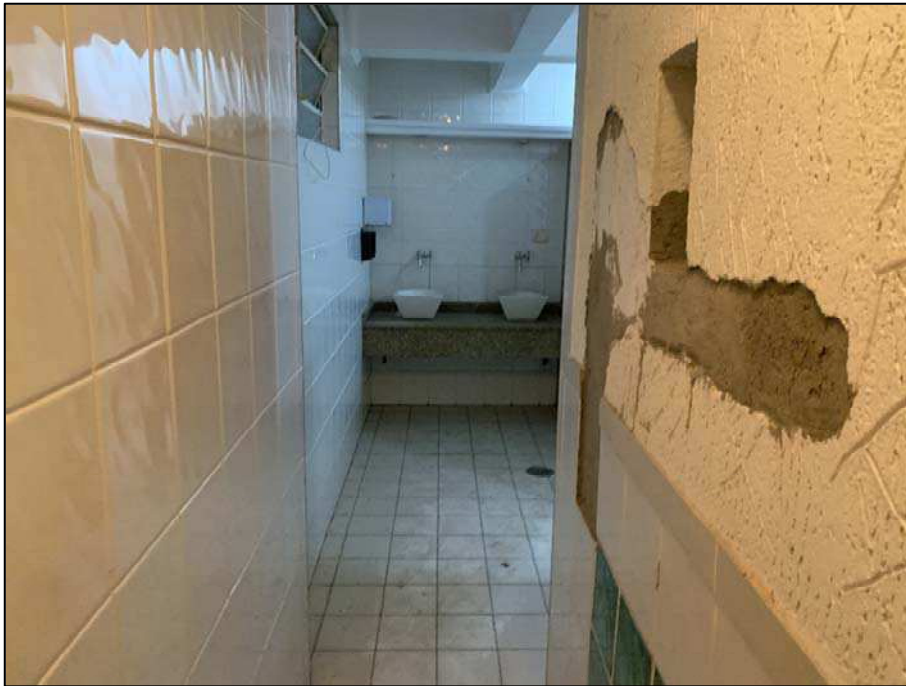
Foto 04. Entrada do banheiro da sala de reunião.
