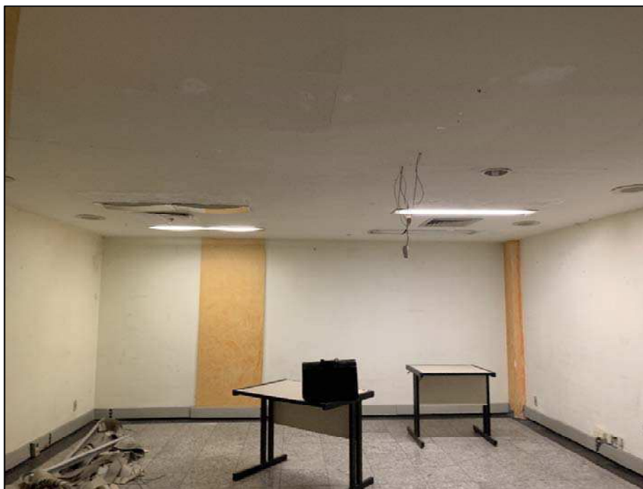
Foto 11. Detalhe do escritório do imóvel avaliando.
