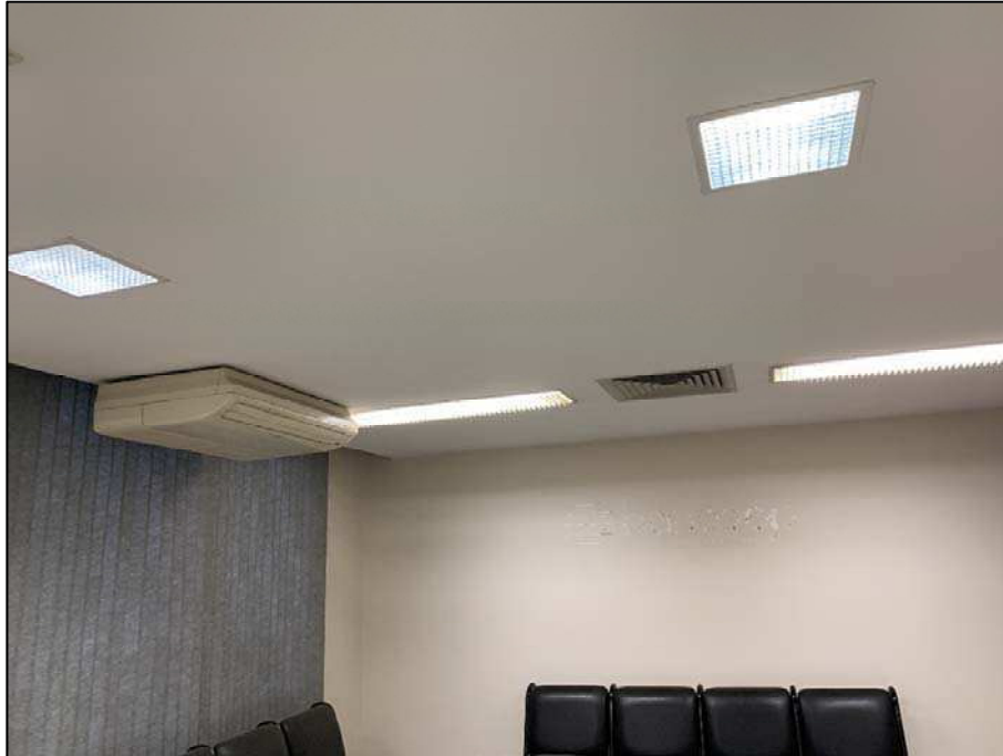
Foto 23. Detalhe do teto da recepção do imóvel avaliando.
