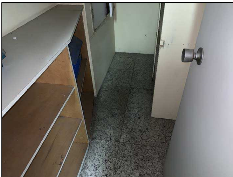
Foto 14. Detalhe do piso do arquivo 1 do imóvel avaliando.
