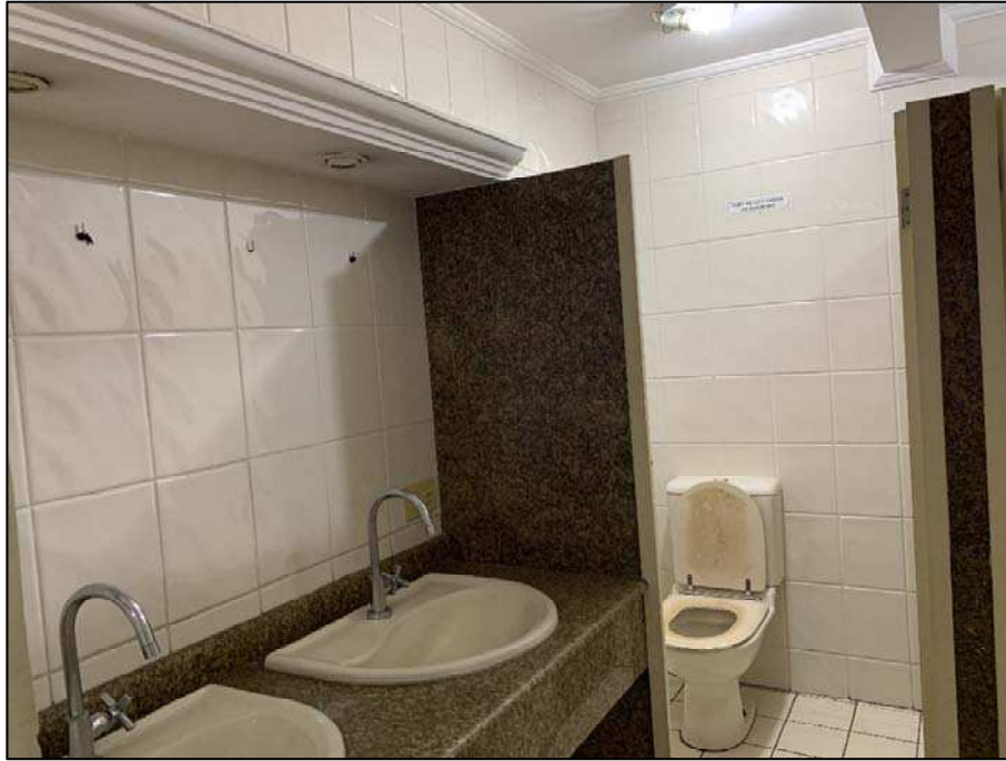
Foto 17. Detalhe do banheiro masculino do imóvel avaliando.
