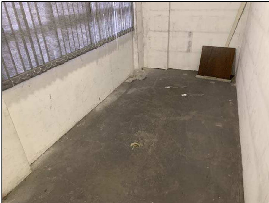
Foto 18. Detalhe do piso do arquivo 2 do imóvel avaliando.
