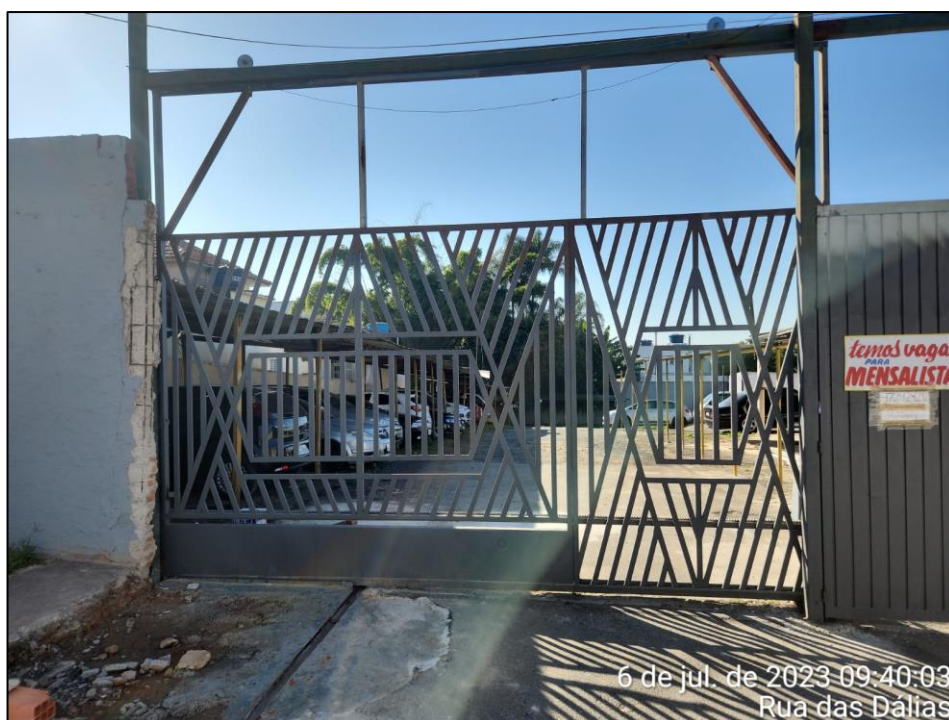
Foto 02 – Frente do imóvel
