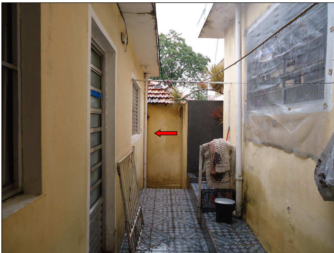
Foto 36: Vista do acesso às construções secundárias (1) e (2) no sentido oposto da Foto 35.
