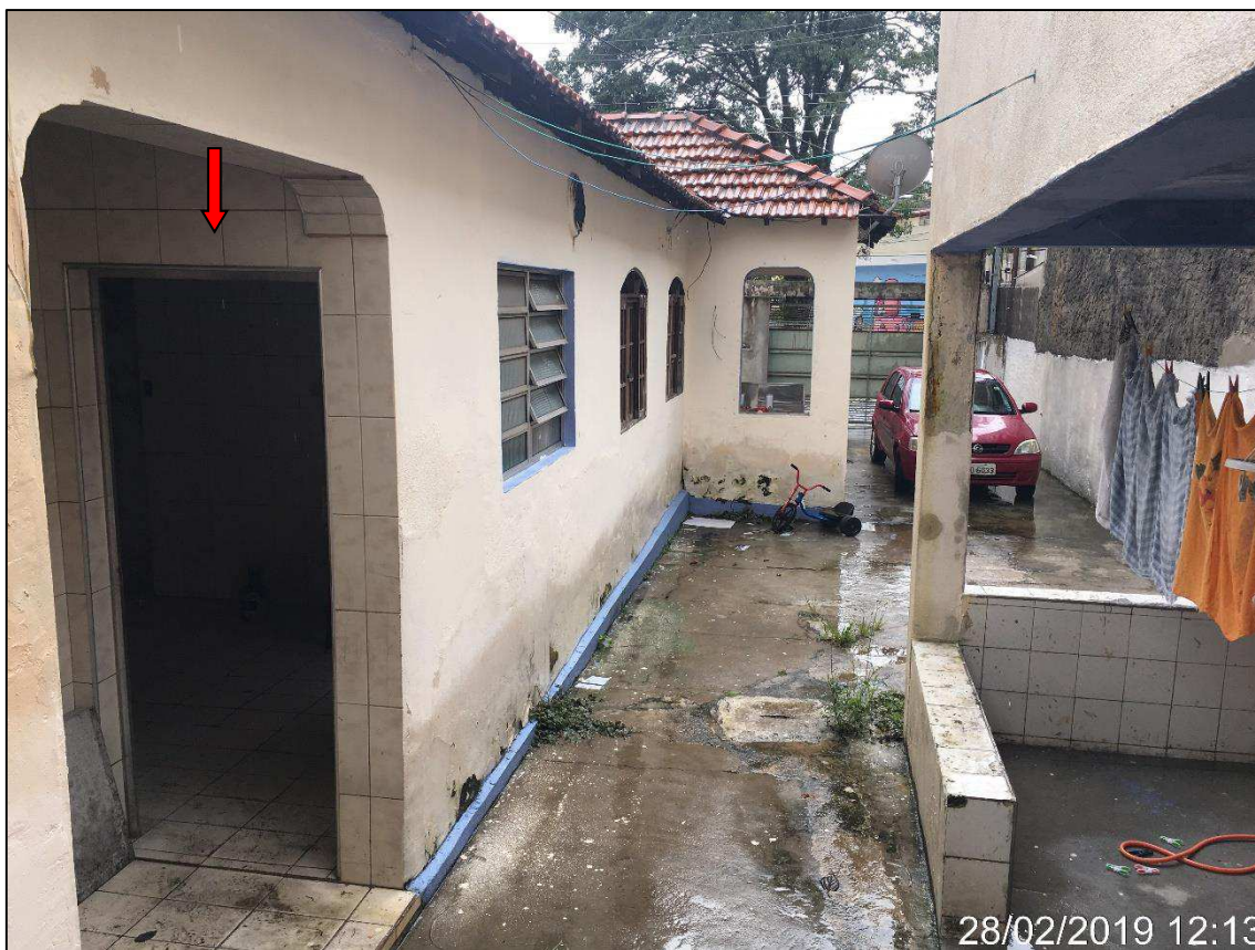
Foto 15: Vista lateral da construção principal destacada a porta de acesso à cozinha.
