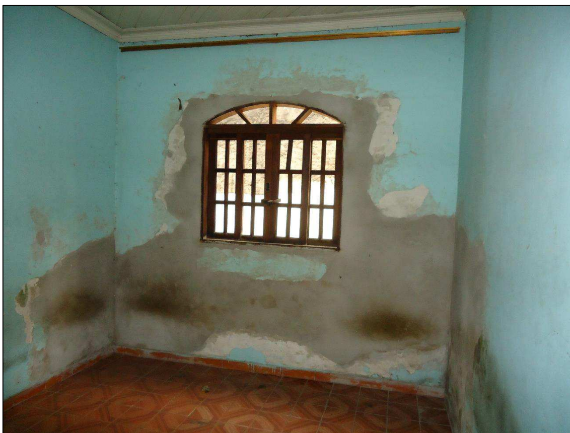
Foto 31: Vista do dormitório (2).
