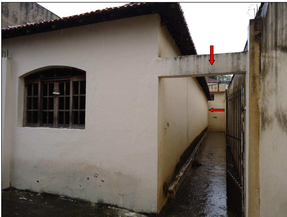
Foto 34: Vista do acesso para as construções secundárias (1) e (2).
