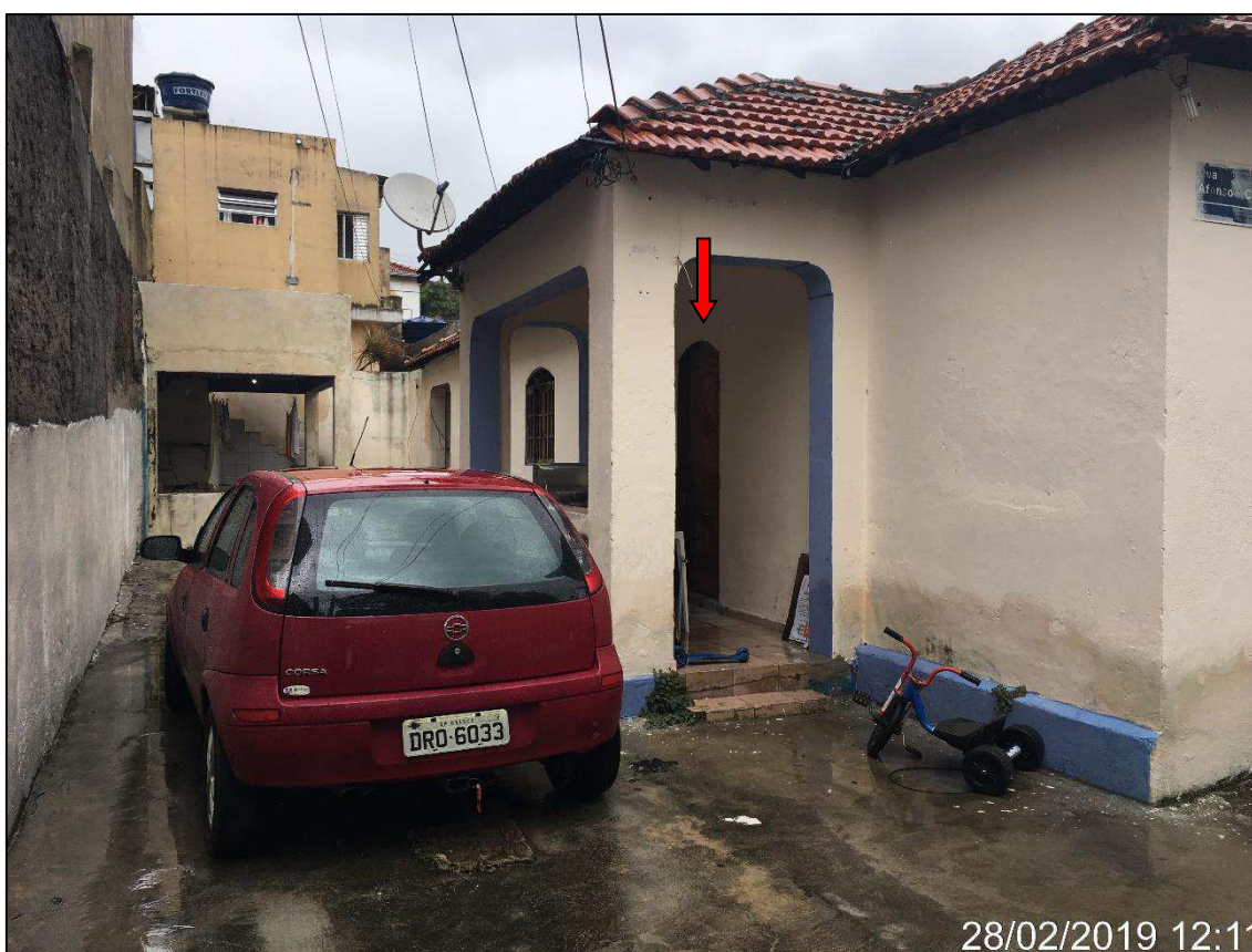
Foto 10: Vista da lateral esquerda da construção principal. Destacada porta de acesso à sala.
