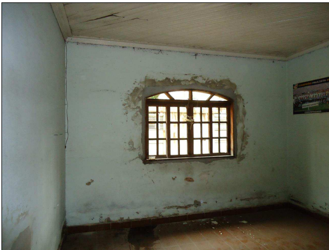
Foto 28: Vista do dormitório (1).
