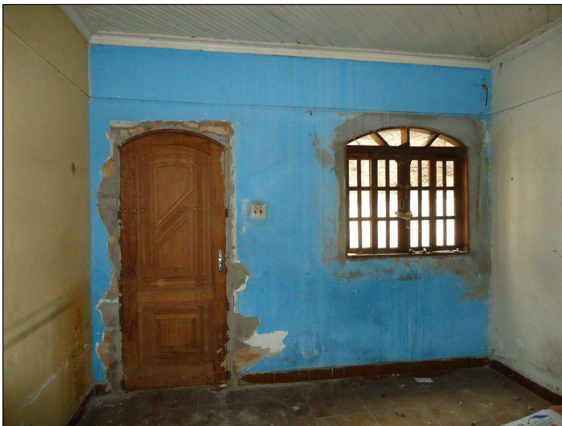
Foto 24: Vista da sala.
