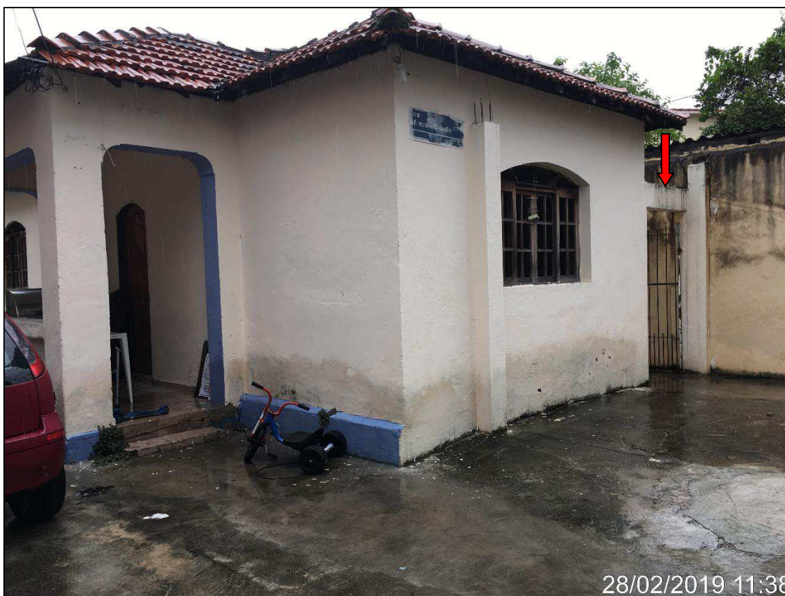
Foto 33: Vista da lateral direita da construção principal. Destacado portão de acesso às construções secundárias (1) e (2).
