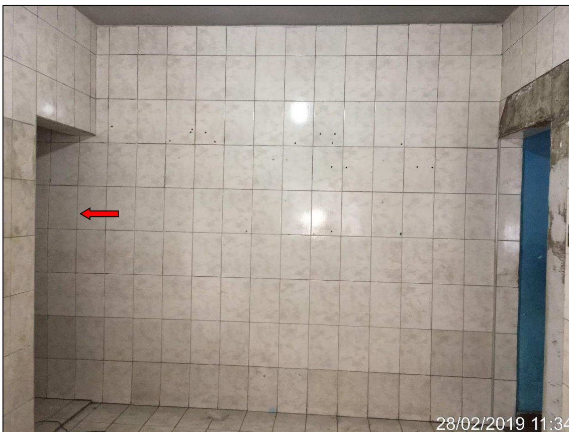
Foto 20: Vista da cozinha e acesso ao banheiro (destacado).
