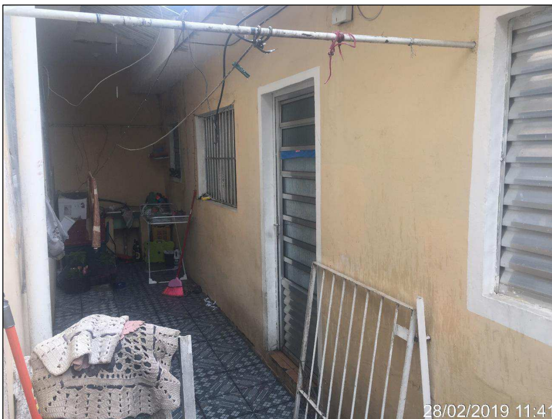
Foto 37: Vista externa da construção secundária (2) no lado direito.
