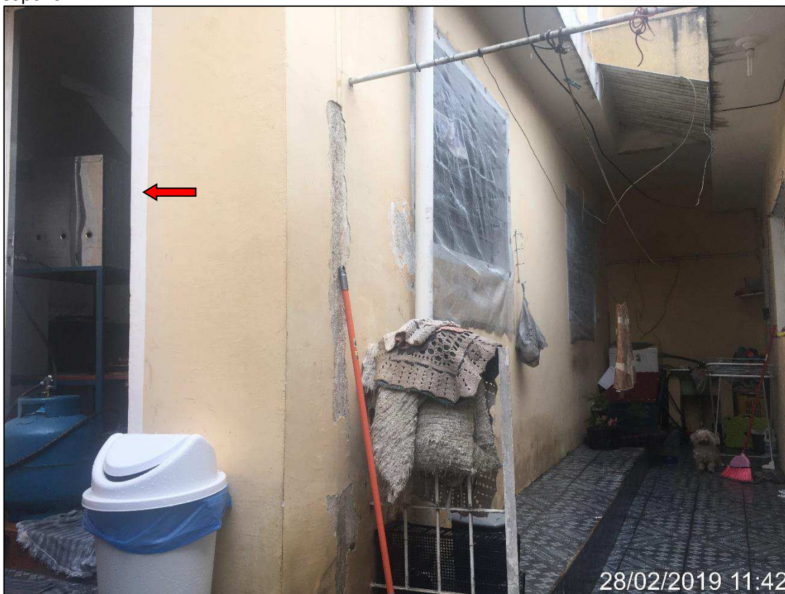
Foto 39: Vista do acesso (destacado) para a construção secundária (1).
