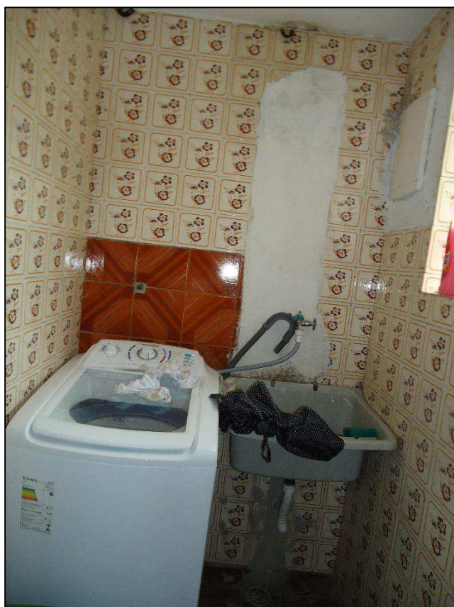
Foto 43: Vista da área de serviço (lavanderia).
