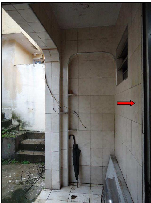
Foto 16: Vista da área coberta na porta (destacada) de acesso à cozinha.
