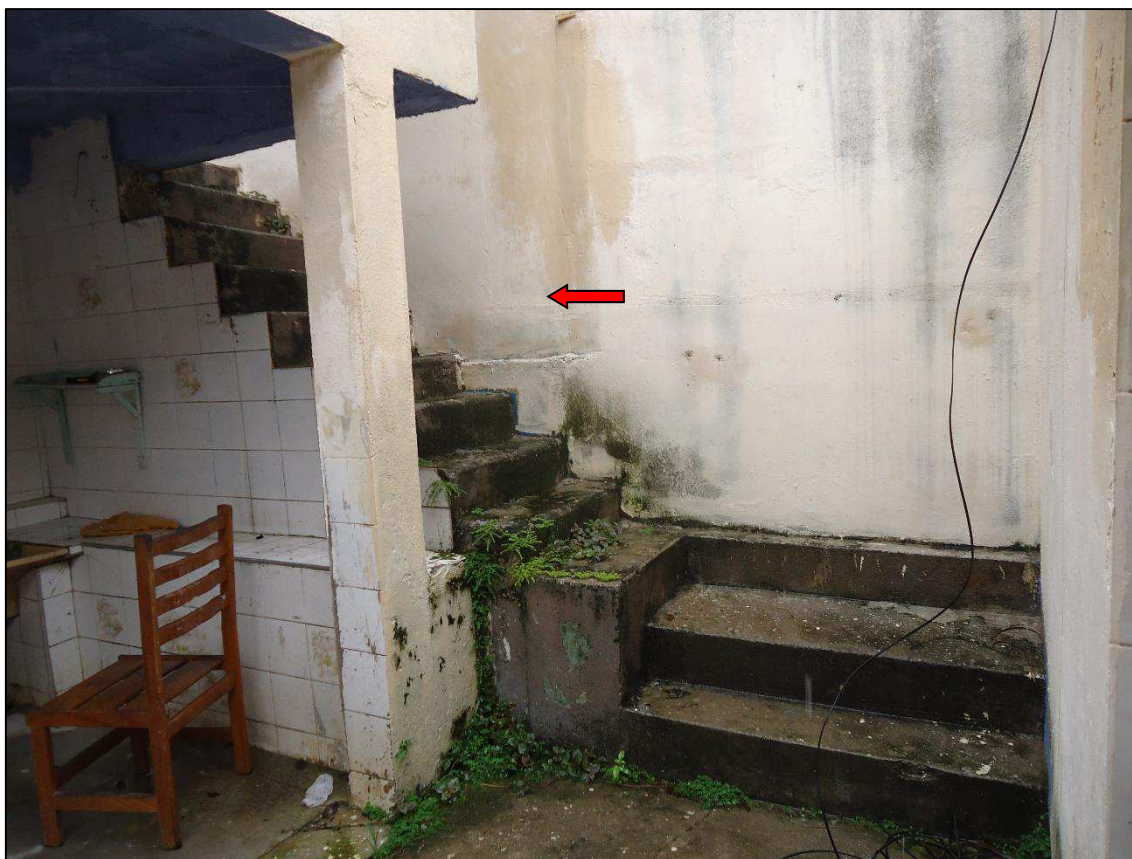
Foto 13: Vista da escada de acesso para área superior da área de serviço (lavanderia) externa.
