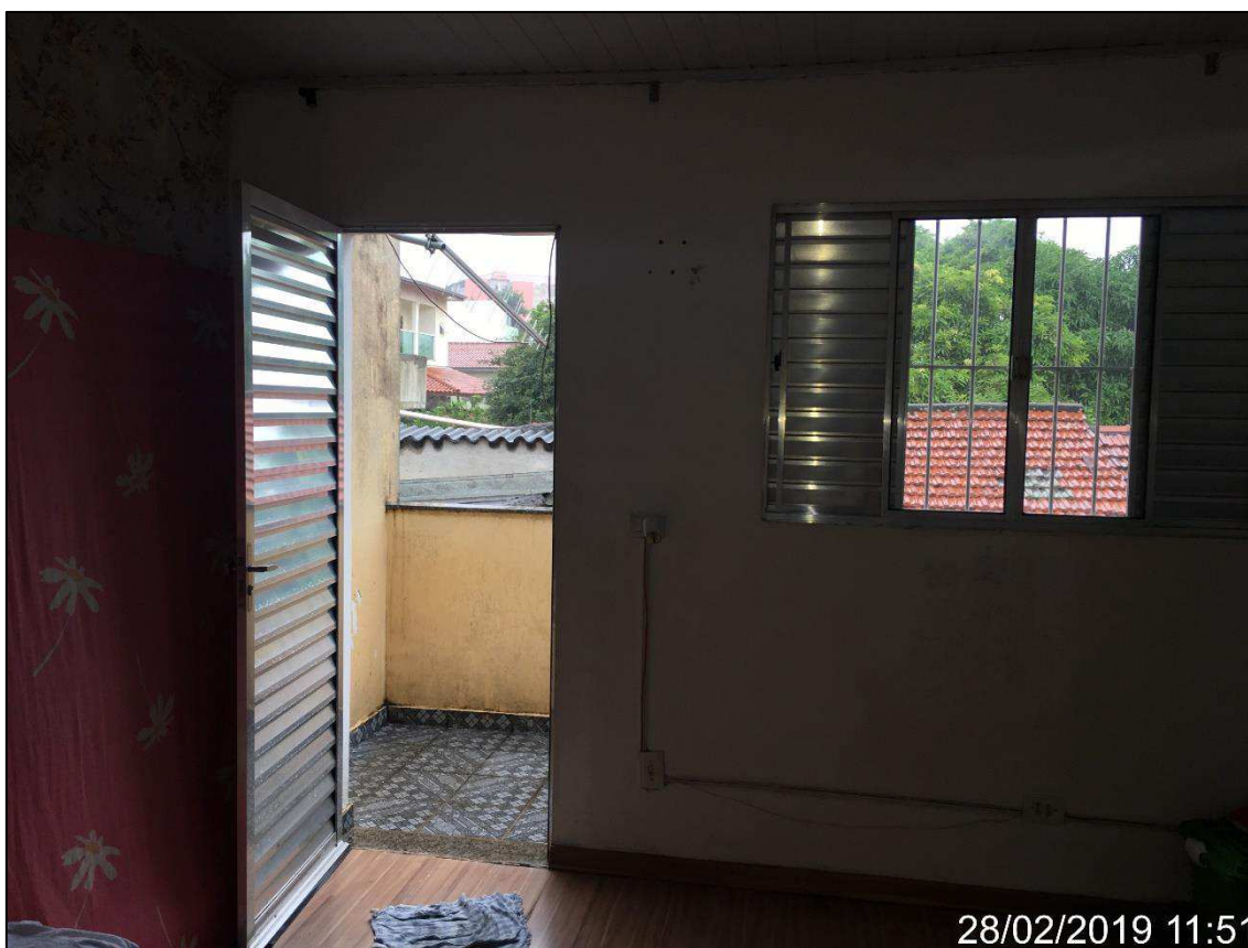
Foto 51: Acesso para a área externa (varanda) do dormitório no pavimento superior.
