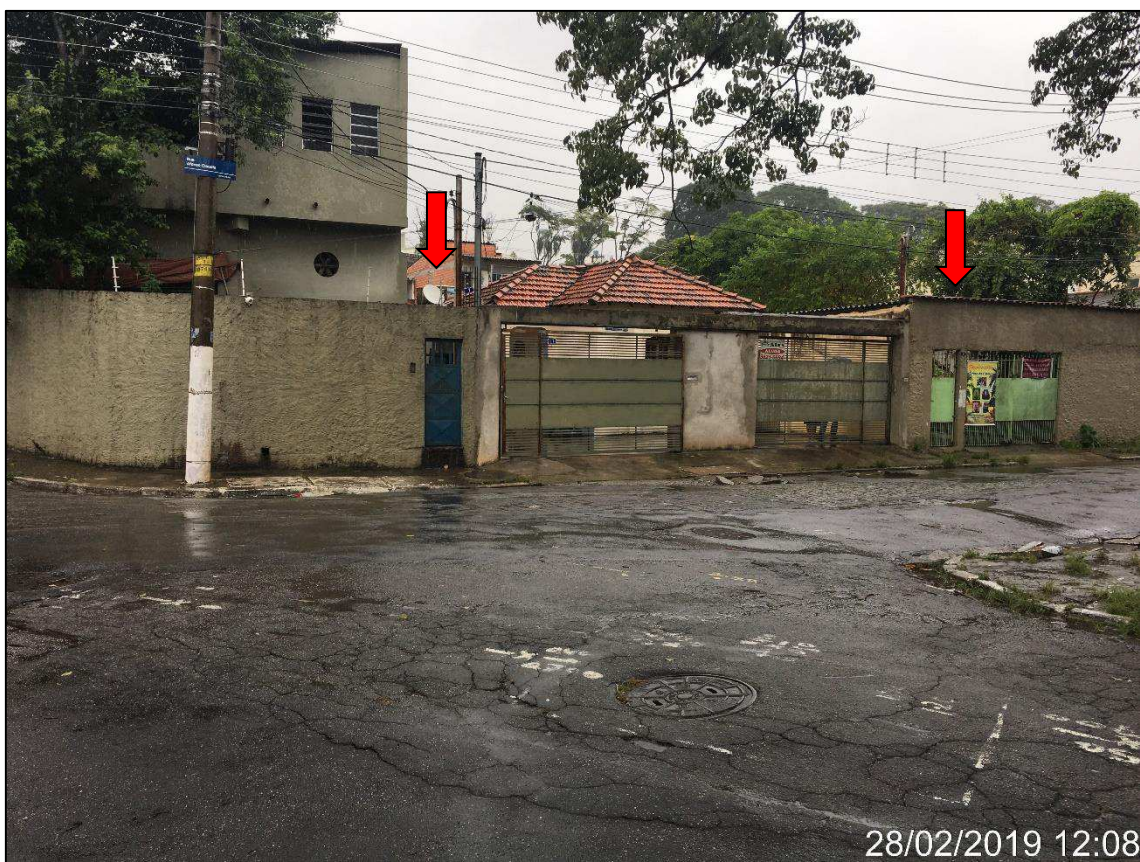
Foto 04: Vista frontal do imóvel avaliando nº11-19 e seus confrontantes laterais, esquerdo nº7 e direito nº21 (destacados).
