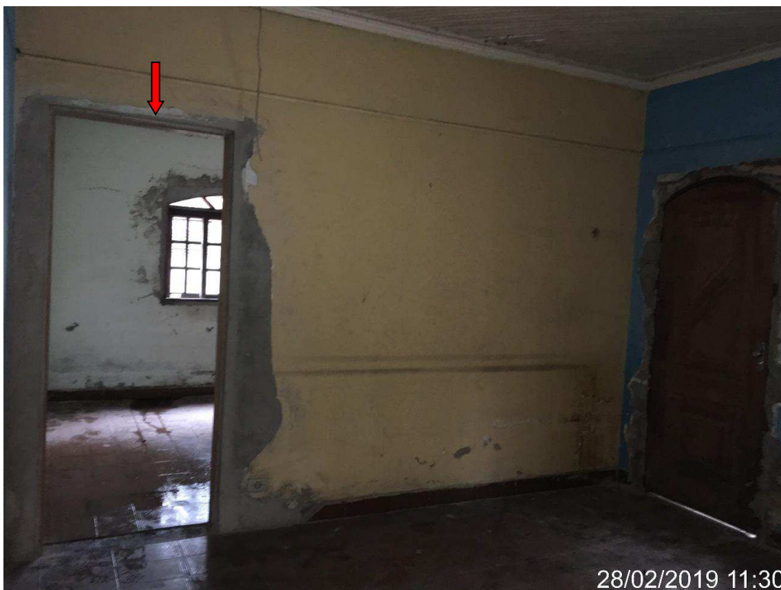
Foto 25: Vista da sala e acesso ao dormitório (1) (destacado).
