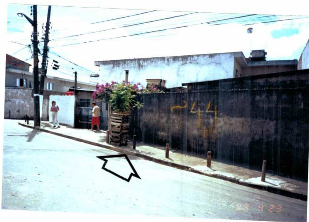
Foto nº4: A fachada lateral do imóvel em tela, estando indicada a testada voltada para a Rua Ferreira de Lemos.
