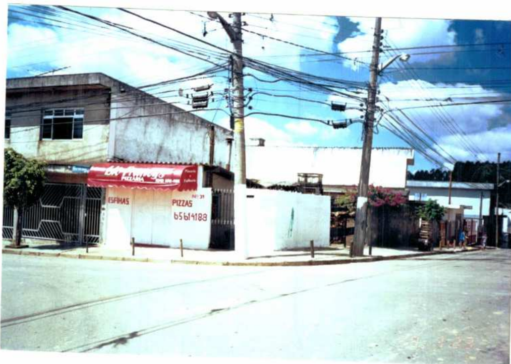
Foto nº3: A fachada frontal do imóvel em tela.
