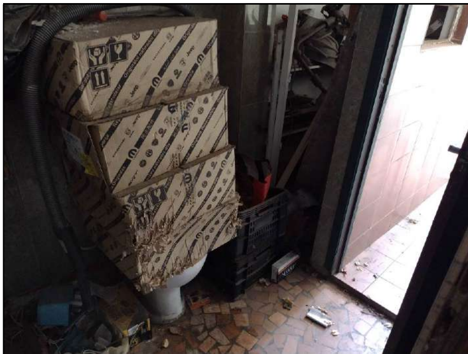
Vista do banheiro.
