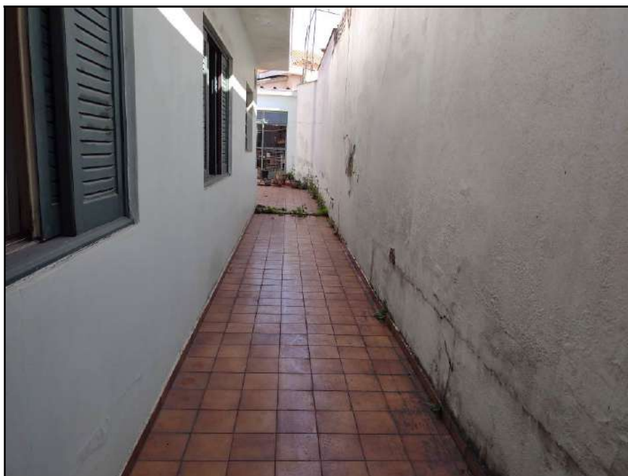
Vista do corredor externo.
