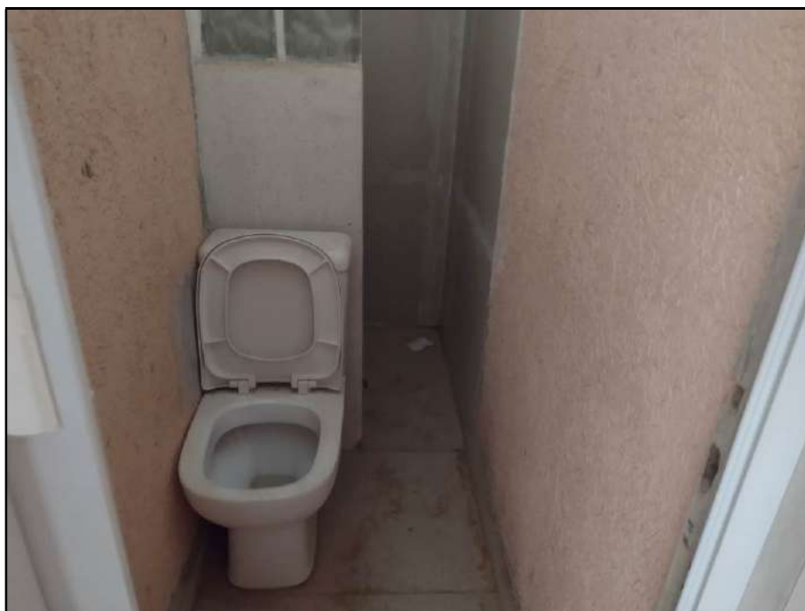
Vista do banheiro.
