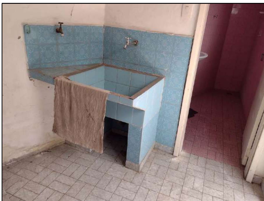
Vista da área de serviço.
