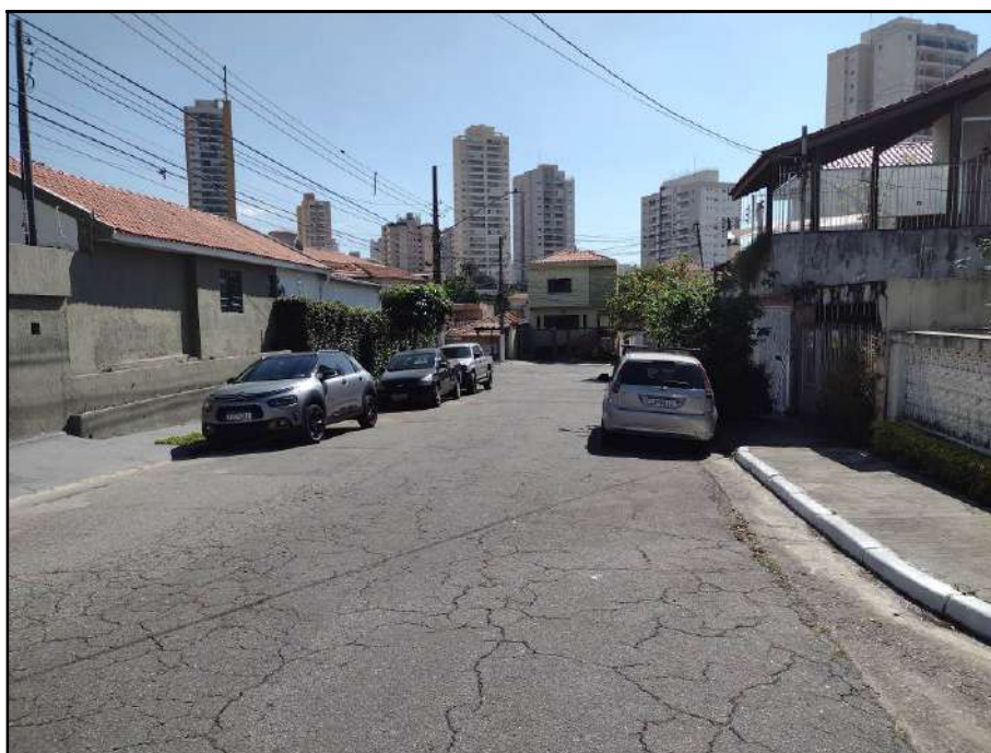
Via de acesso: Rua Guaripe.
