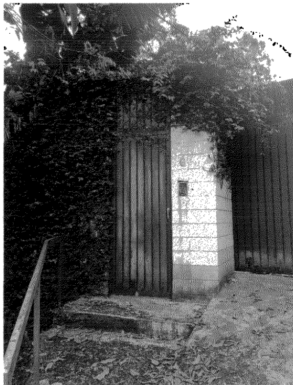
Foto 2: Fachada do imóvel avaliando
