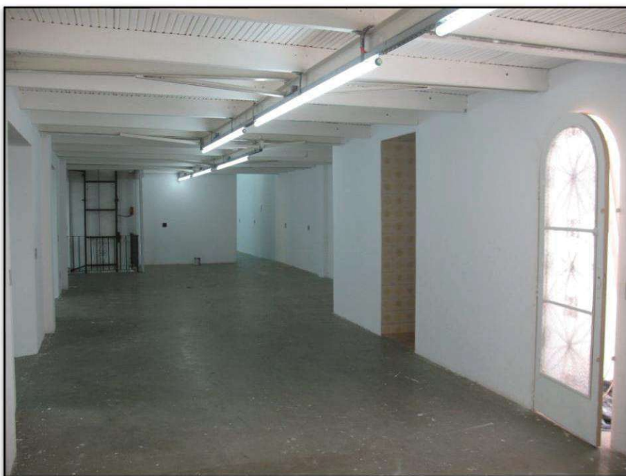
Foto nº 14 - Vista interna do imóvel – imagem fornecida pelo autor.
