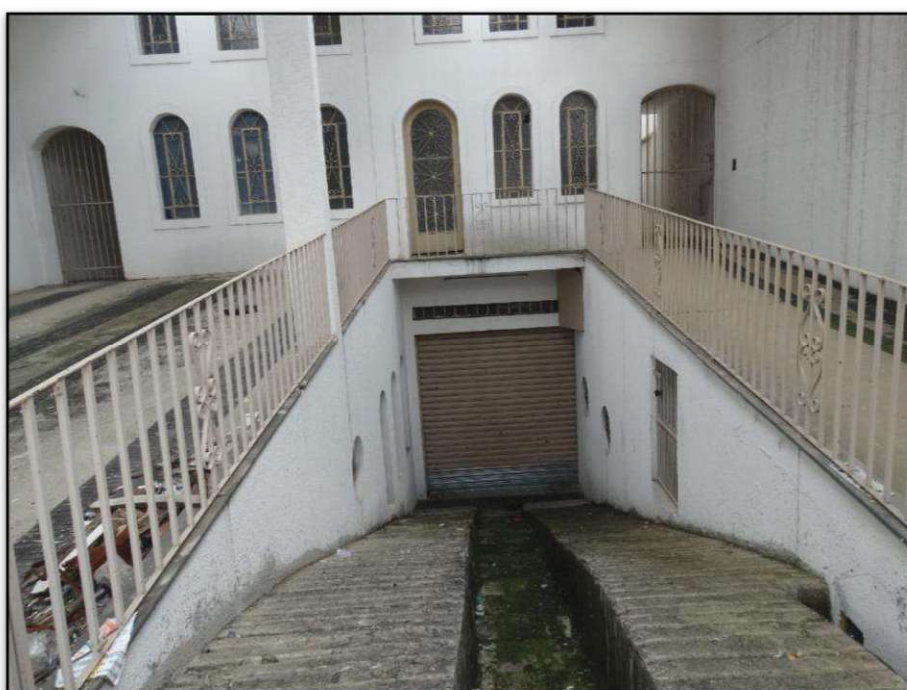
Foto nº 6 - Vista frontal do imóvel objeto da presente avaliação – rampa de acesso ao subsolo.
