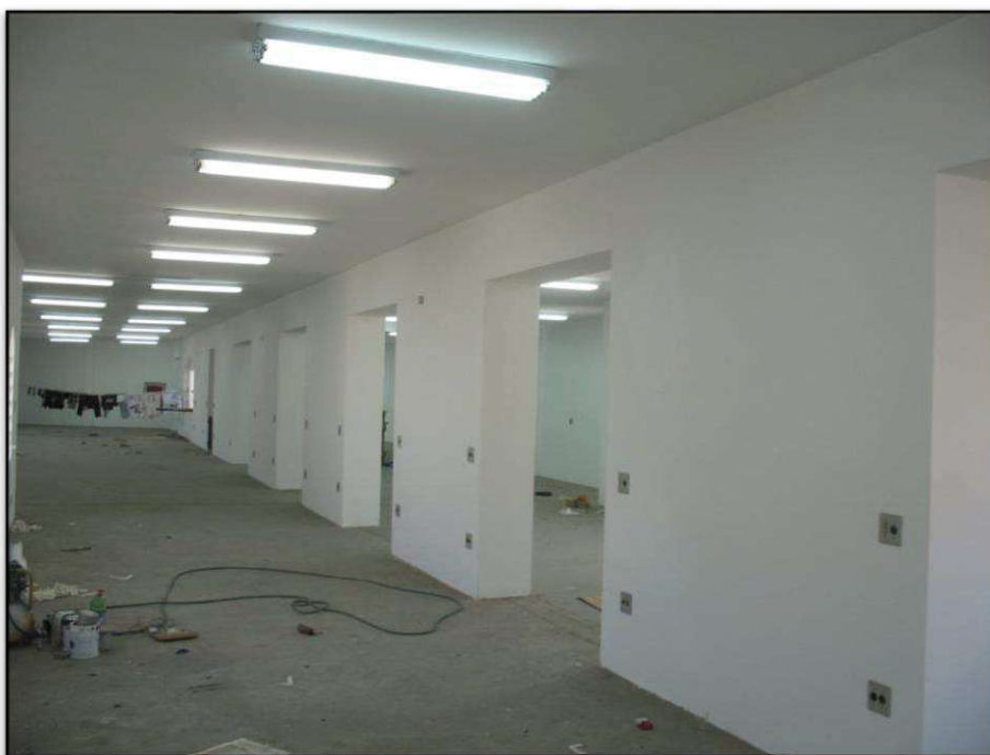
Foto nº 15 - Vista interna do imóvel – imagem fornecida pelo autor.
