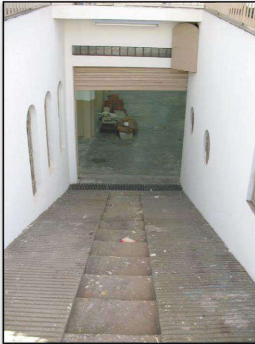
Foto nº 17 - Vista da rampa de acesso ao subsolo do imóvel – imagem fornecida pelo autor.
