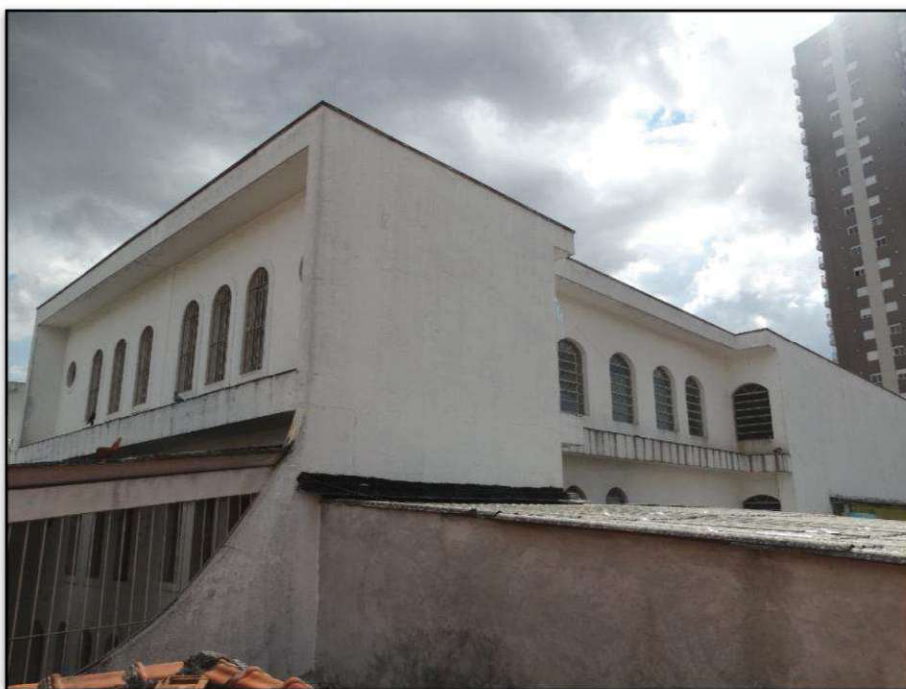
Foto nº 4 - Vista da fachada lateral esquerda da edificação.
