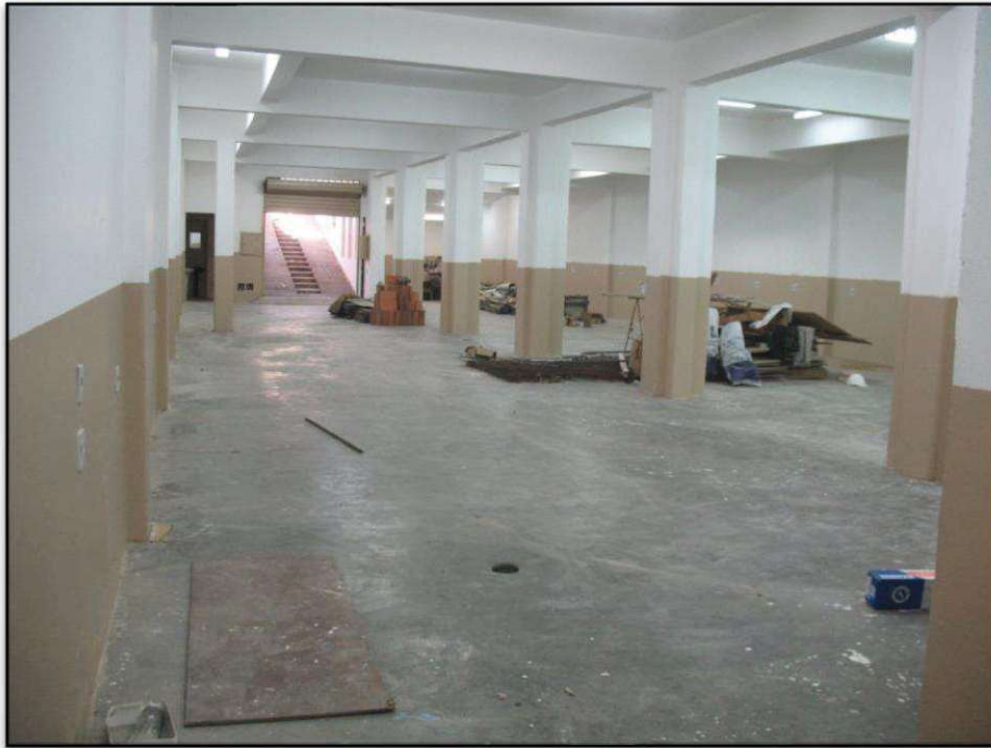
Foto nº 7 - Vista interna do subsolo do imóvel – imagem fornecida pelo autor.
