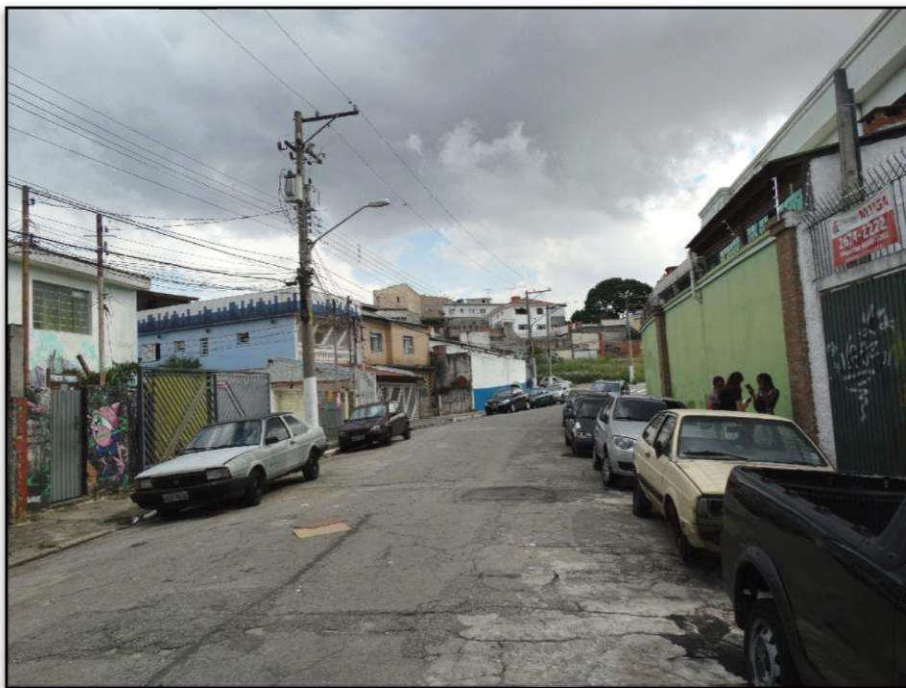
Foto nº 3 - Vista geral da Rua São Constâncio em direção à Rua Pretória.
