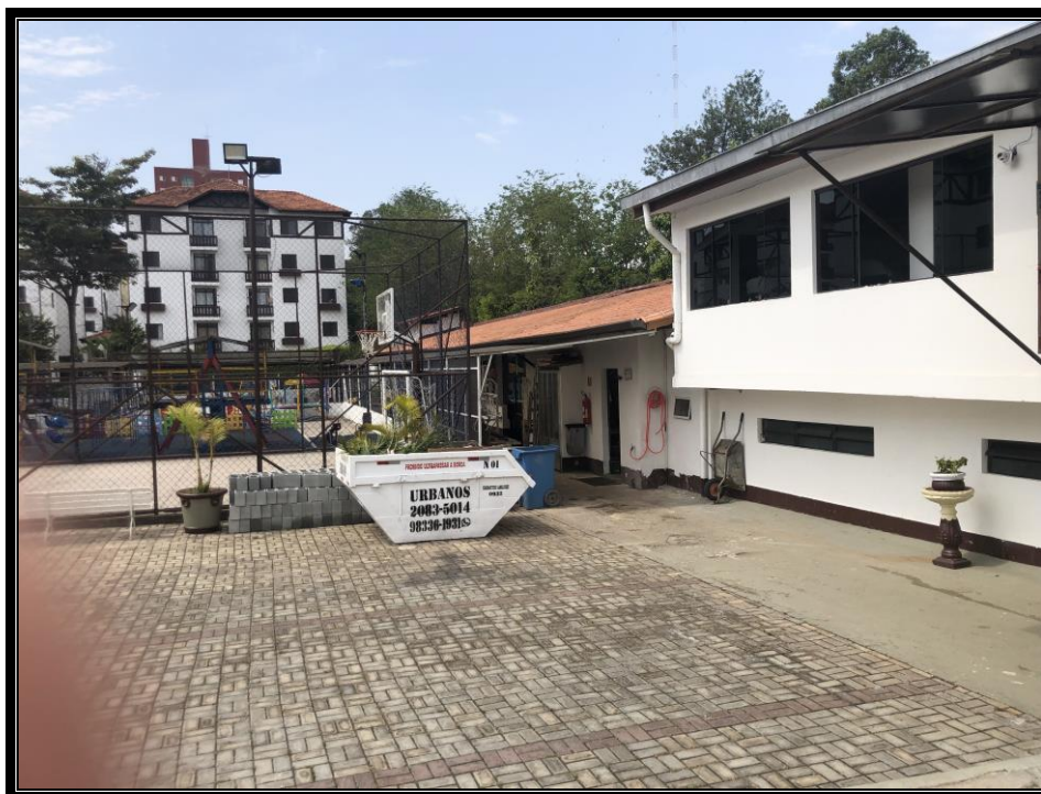
Foto – Áreas de Lazer no condomínio.
