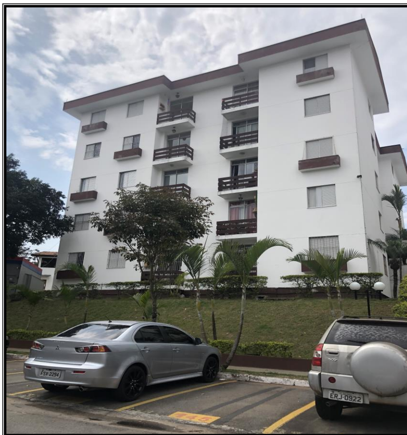
Vista de um dos blocos do condomínio.
