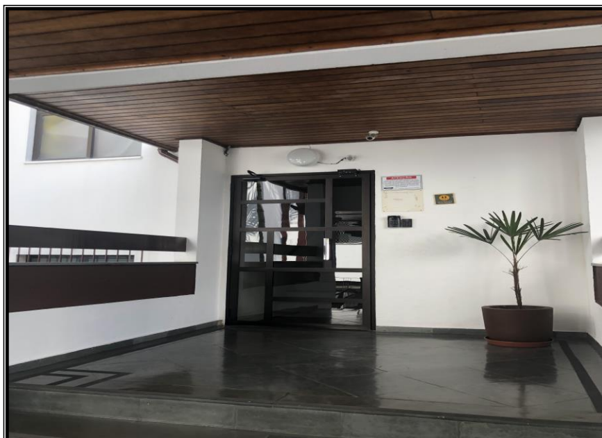
Foto – Térreo com vista para entrada do bloco 25 do avaliando.
