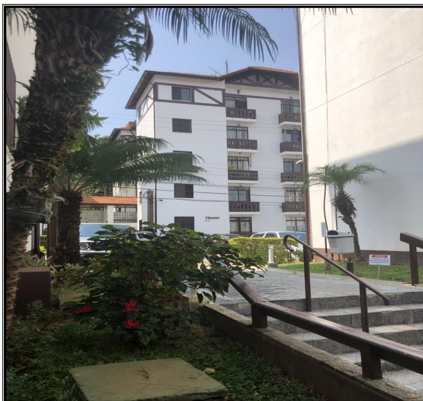
Foto – Outra vista acesso aos blocos.
