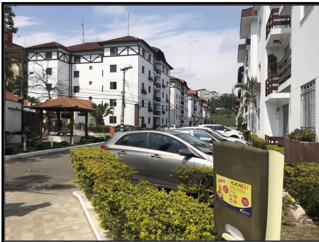
Foto – Vista geral do condomínio.
