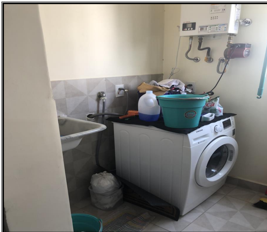
Foto – Lavanderia da unidade.
