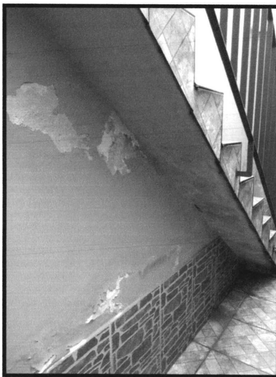
Figura 27: Detalhe da área da parede sob a escada lateral
