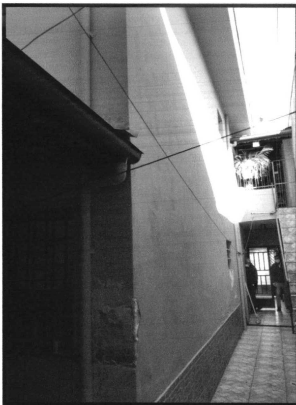
Figura 22: Detalhe da parede lateral da construção, vista para a frente do imóvel
