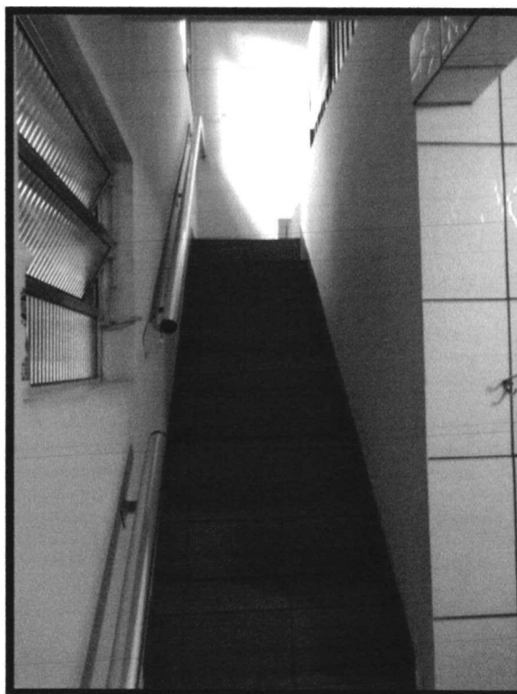
Figura 39: Escada de acesso ao escritório
