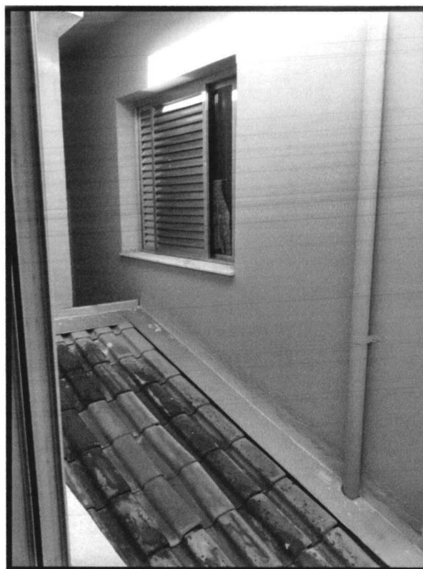
Figura 46: Vista área externa a partir do escritório, detalhe cobertura da lavanderia
