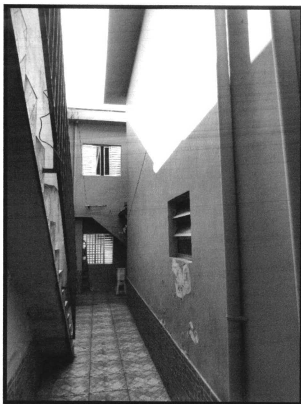
Figura 20: Corredor lateral, vista para os fundos Fonte: Autoria própria (2022)
