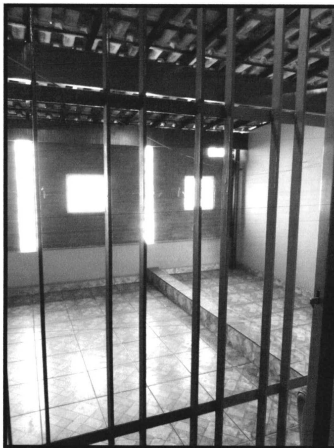
Figura 57: Área sobre garagem, vista a partir do dormitório nº 2
