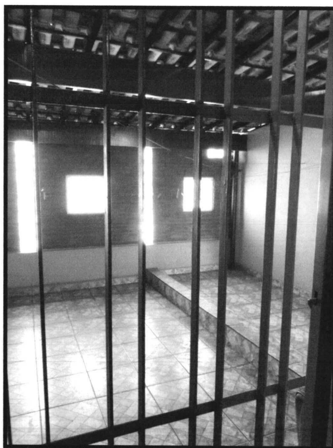
Figura 57: Área sobre garagem, vista a partir do dormitório nº 2 Fonte: Aatoria própria (2022)
