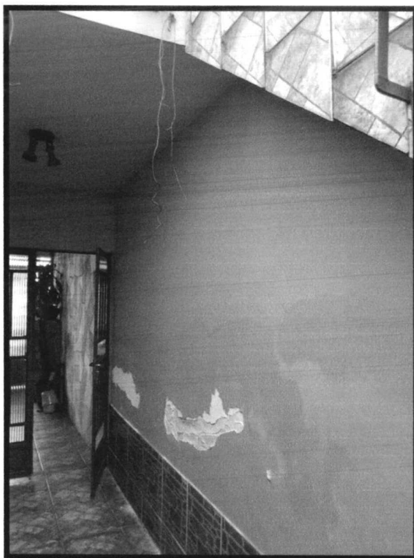
Figura 26: Detalhe da área da parede de divisa sob a projeção da escada lateral
