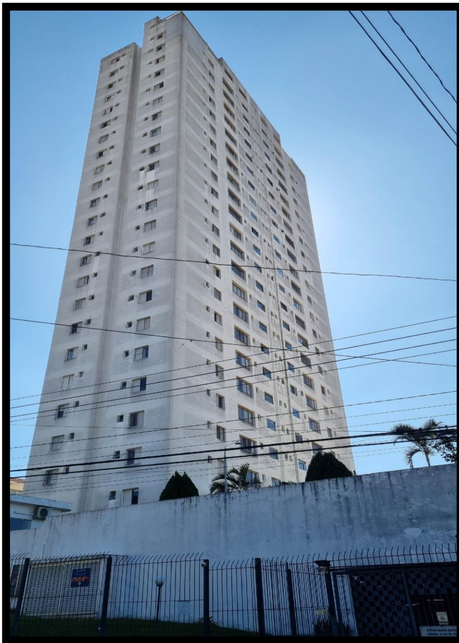
VISTA DA FACHADA DO “CONDOMÍNIO EDIFÍCIO OXFORD”, TOMADA PELA LATERAL DIREITA.
