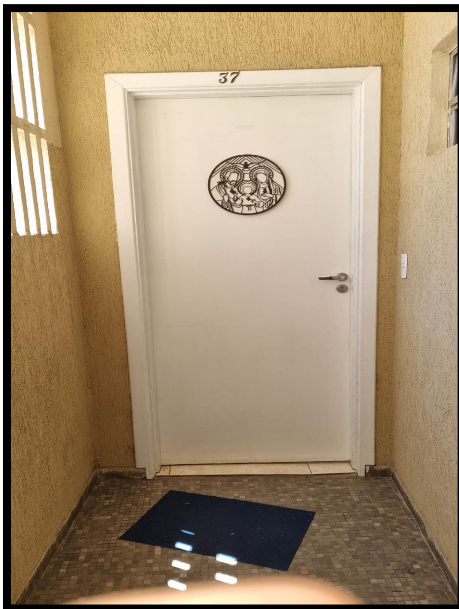
VISTA DA PORTA QUE DÁ ACESSO AO APARTAMENTO DE Nº 37 DO “EDIFÍCIO ANGATUBA”.
