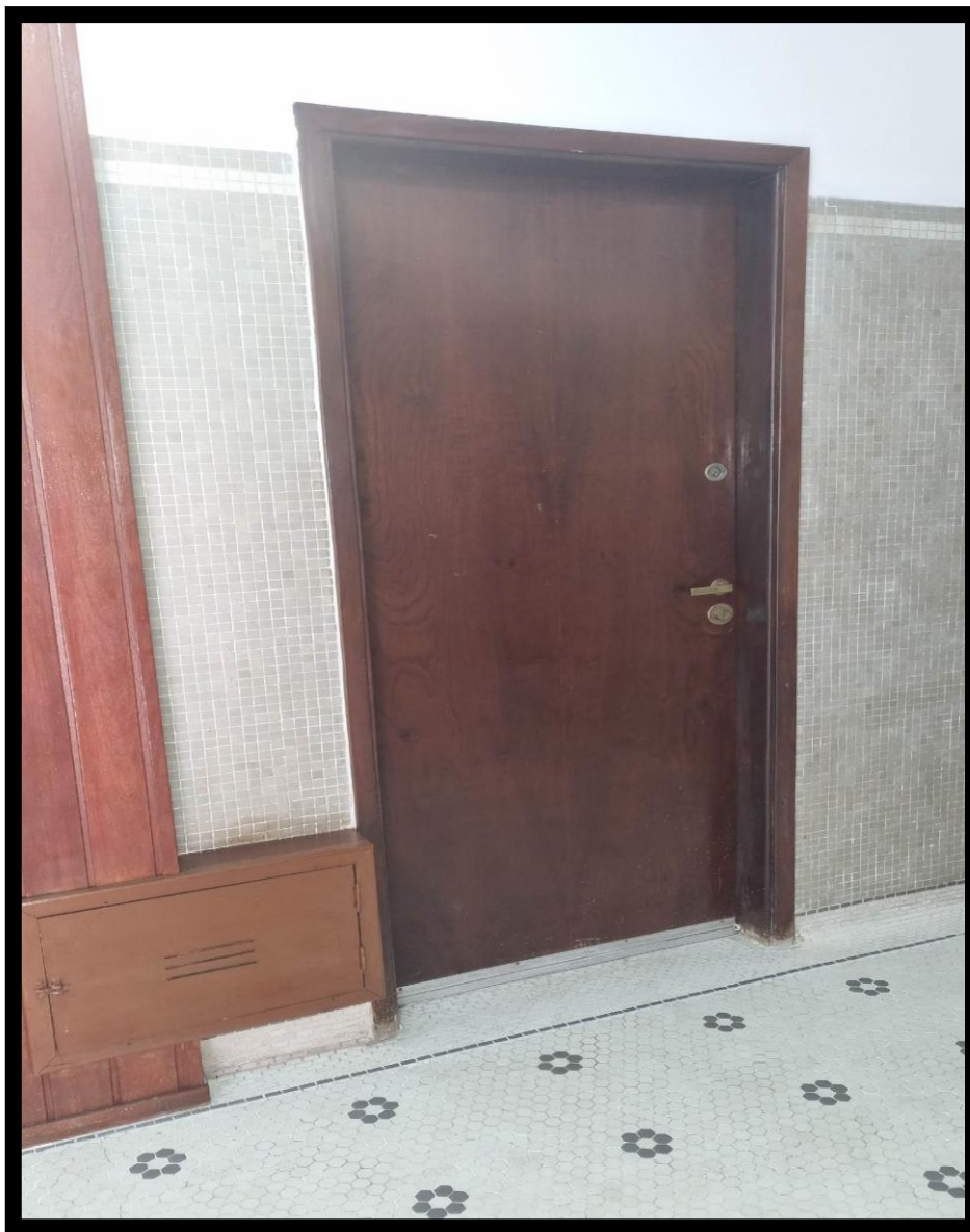
VISTA DA PORTA DE ENTRADA DE SERVIÇOS, QUE DÁ ACESSO AO APARTAMENTO DE Nº 31 DO “EDIFÍCIO PAULISTÂNIA”.
