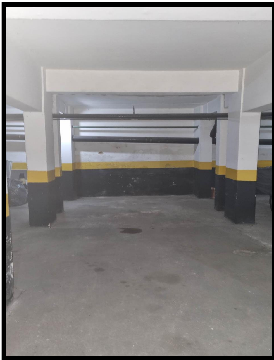
VISTA DA VAGA DE GARAGEM, PERTENCENTE AO APARTAMENTO DE Nº 31 DO “EDIFÍCIO PAULISTÂNIA”.
