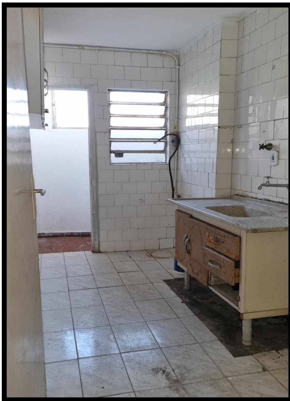
VISTA DA COZINHA.
