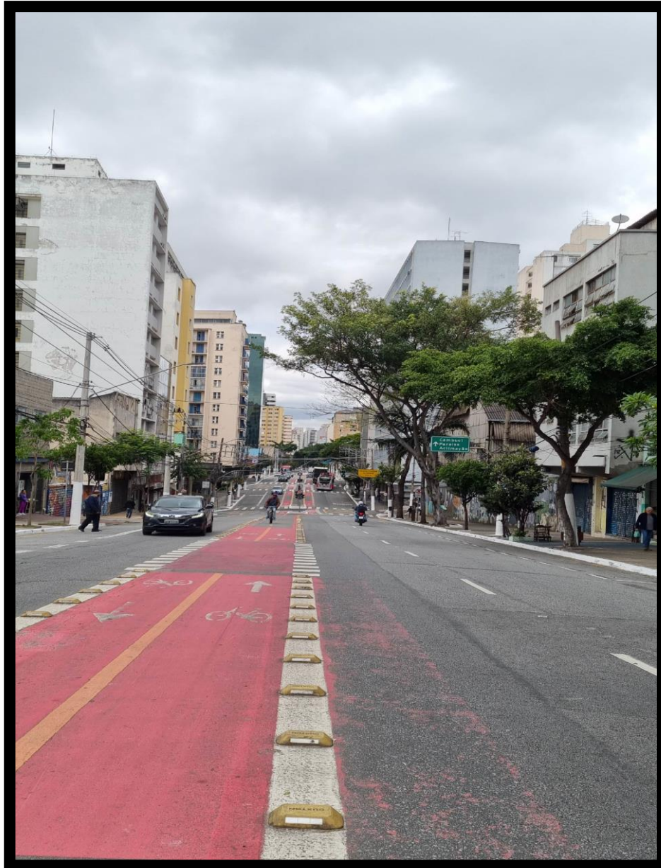
VISTA DA RUA CONSELHEIRO FURTADO, NO TRECHO ONDE ESTÁ SITUADO O “EDIFÍCIO COLORADO”, ONDE SE LOCALIZA O IMÓVEL AVALIANDO.
