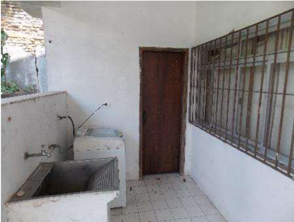
Foto nº 15 – Área de serviço.
