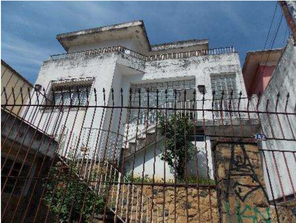
Foto nº 3 – Fachada frontal do imóvel.
