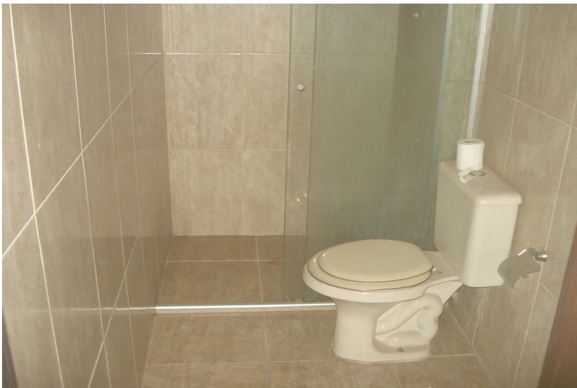
FOTO Nº 15 – Vista do banheiro social no apartamento avaliando.
