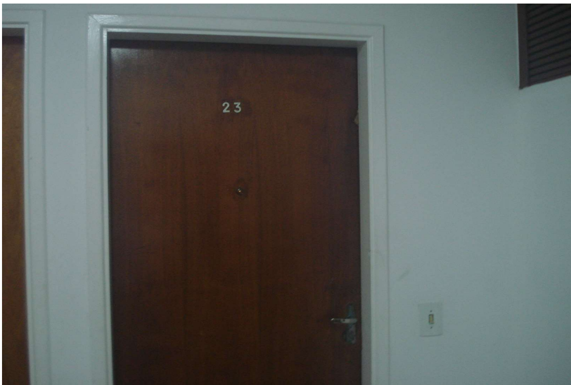
FOTO N° 05 – Vista da porta de entrada do apartamento avaliando
