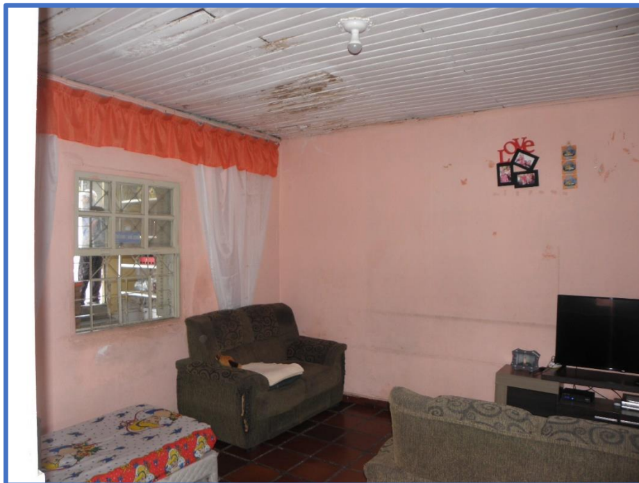
Foto: Vista da sala, térreo.
