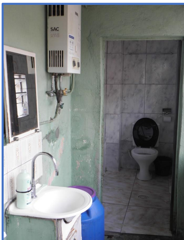
Foto: vista do banheiro, térreo.
