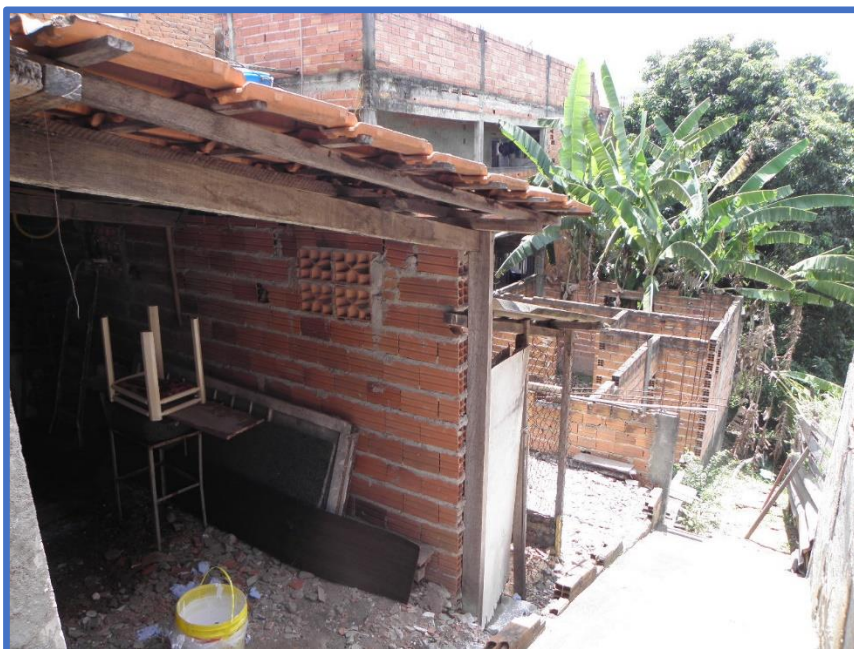
Foto: Acesso lateral, com obras inacabadas ao fundo do terreno.
