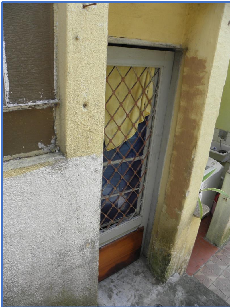
Foto: 1º ambiente, com acesso lateral, com 01 quarto e 01 banheiro. Obs.: Não foi possível verificar, pois havia crianças dormindo.
