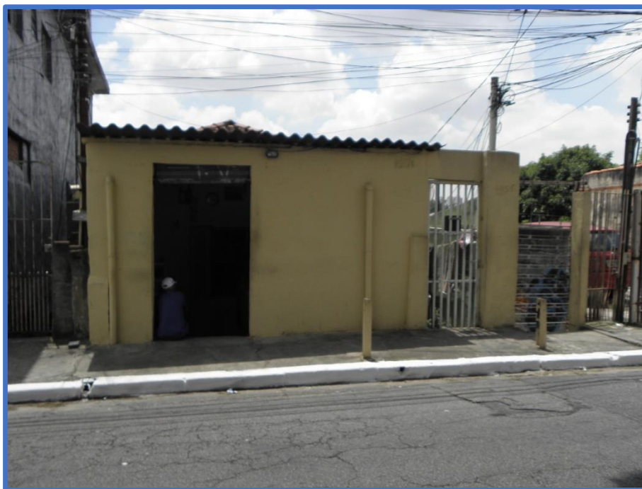
Foto: Vista da fachada do imóvel objeto.
