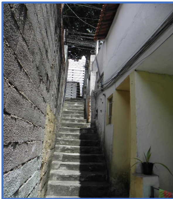
Foto: Vista da escada lateral de acesso aos fundos do terreno, em declive, onde se encontram 04 (quatro) ambientes individualizados, e acesso à área de quintal aos fundos.
