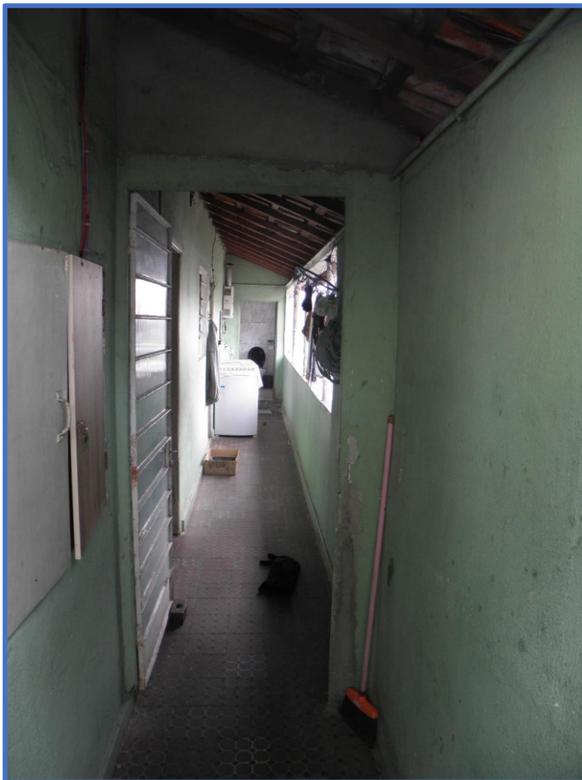
Foto: Vista do corredor de entrada, térreo.
