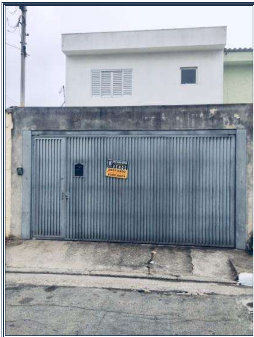
Vista da frente do imóvel avaliando.
