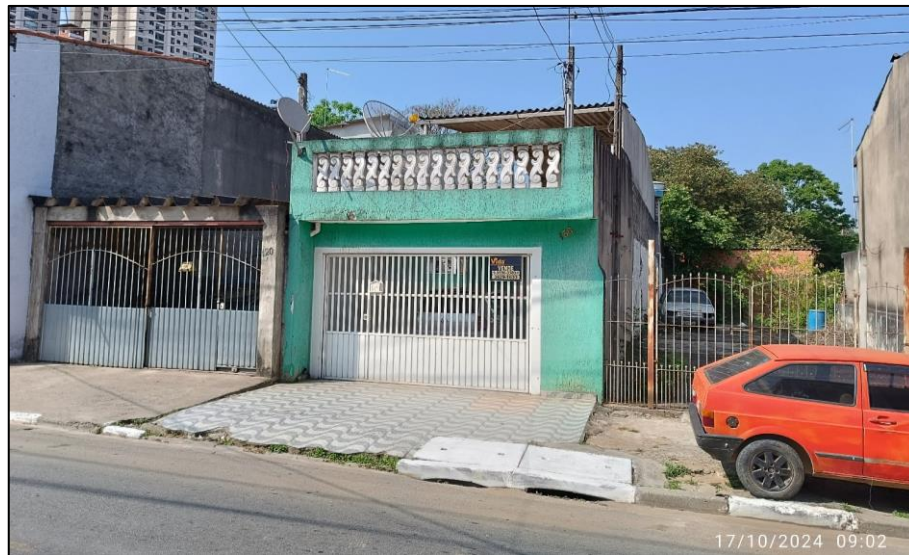
Figura 6: Vista da fachada do imóvel avaliando.
