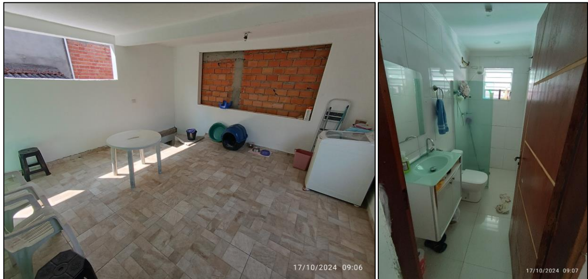
Figura 10: Área de serviço e banheiro localizados no térreo.
