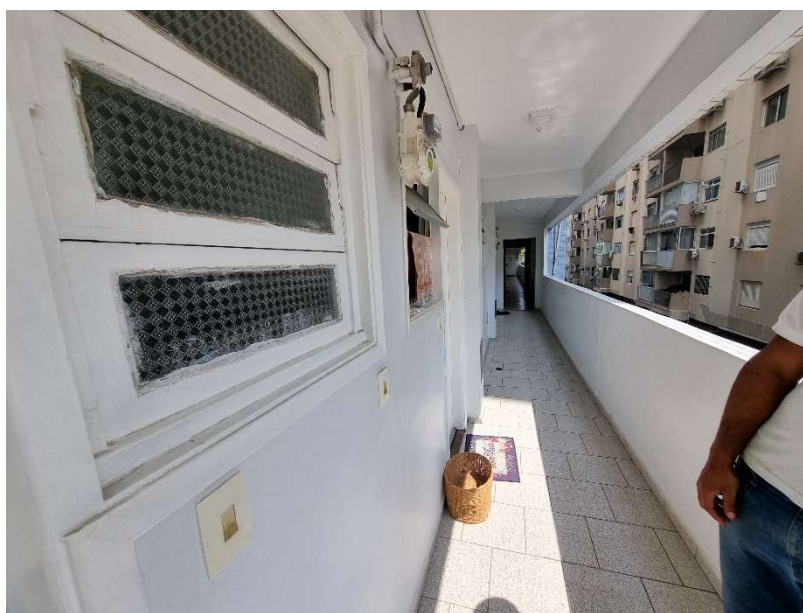
Foto 12 - Vista do corredor de circulação do 2º andar do bloco Mandarin.
