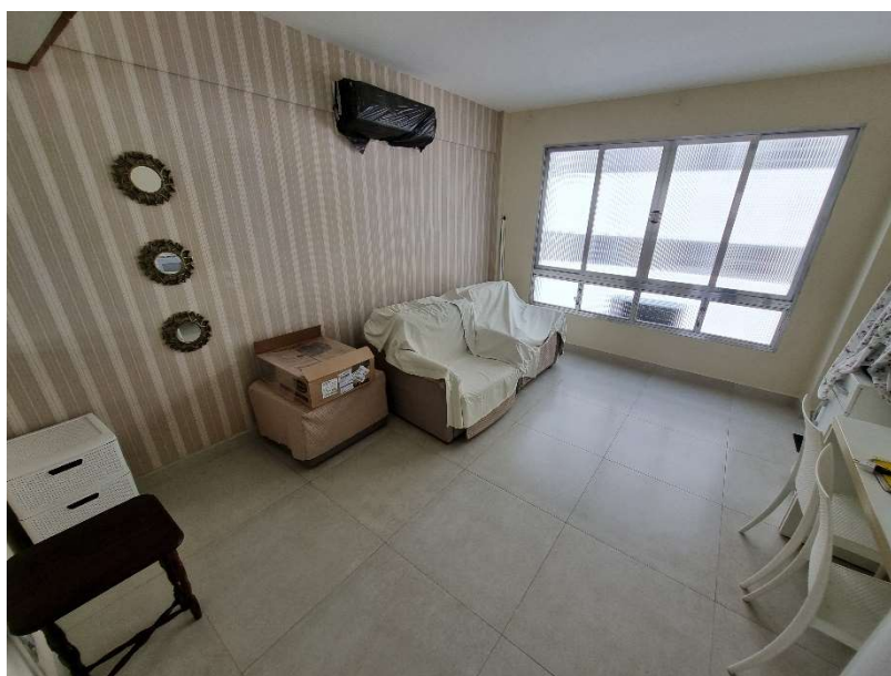
Foto 16 – Vista do cômodo integrado sala/dormitório da unidade privativa 1.110, unidade similar ao imóvel avaliando, apresentando as seguintes características construtivas: piso em revestimento cerâmico; paredes revestidas parte em papel de parede, parte em pintura látex PVA sobre massa corrida; teto em pintura látex PVA sobre massa corrida; esquadrias da janela em alumínio.
