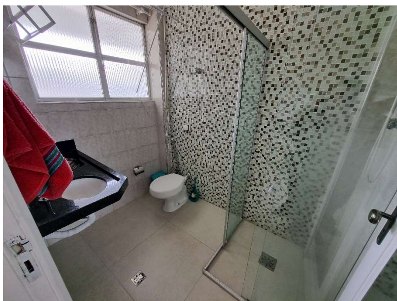
Foto 15 - Vista do banheiro da unidade privativa 1.110, unidade similar ao imóvel avaliando, apresentando as seguintes características construtivas: piso e paredes em revestimento cerâmico; teto em pintura látex PVA sobre massa corrida com acabamento em molduras de gesso; esquadrias da porta em madeira e janela em alumínio.
