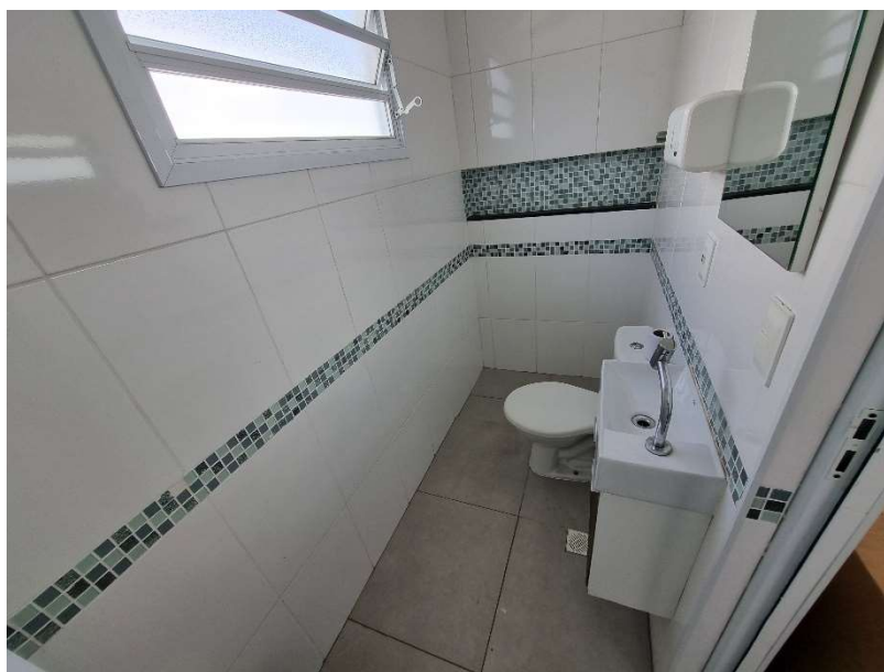
Foto 19 – Vista do banheiro do Salão de Festas do bloco Mandarin.
