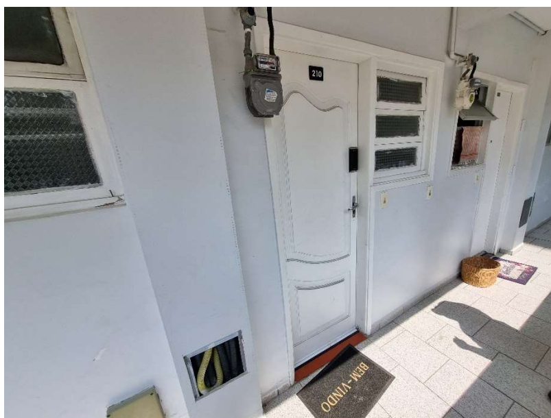
Foto 10 - Vista do acesso à unidade privativa 210 do bloco Mandarin, imóvel avaliando o qual não foi possível adentrar.
