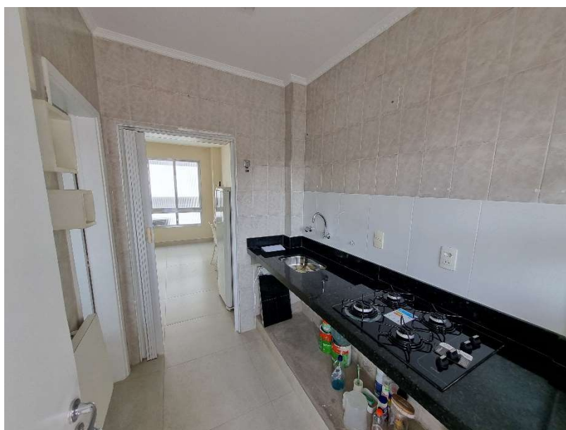
Foto 14 - Vista da cozinha da unidade privativa 1.110, unidade similar ao imóvel avaliando, apresentando as seguintes características construtivas: piso e paredes em revestimento cerâmico; teto em pintura látex PVA sobre massa corrida com acabamento em molduras de gesso; esquadrias da porta de acesso ao imóvel em madeira, da porta que interliga o outro cômodo de PVC e da janela em alumínio.
