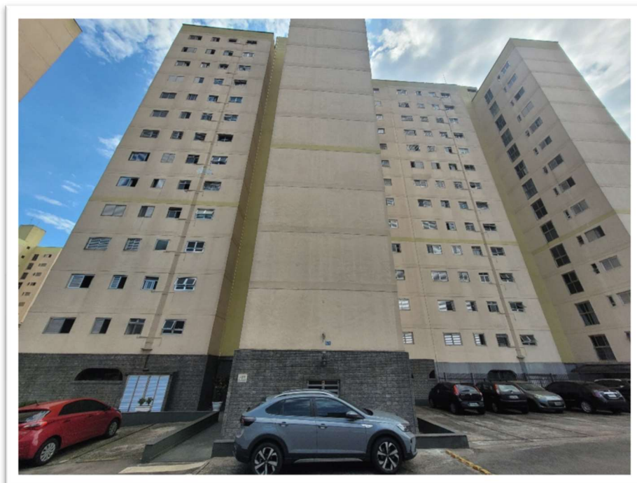
FOTO 03 – FACHADA DO BLOCO 14
