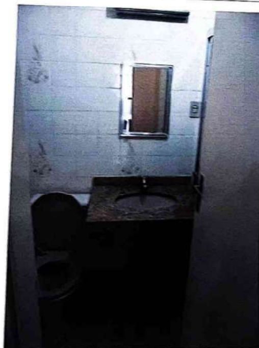
VISTA DO PADRÃO CONSTRUTIVO DO BANHEIRO.
